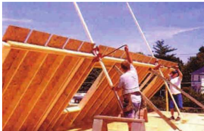
Fig. 72, Colocación de tableros en su lugar correspondiente. Fuente, “La Construcción de Viviendas en Madera”, p. 125
