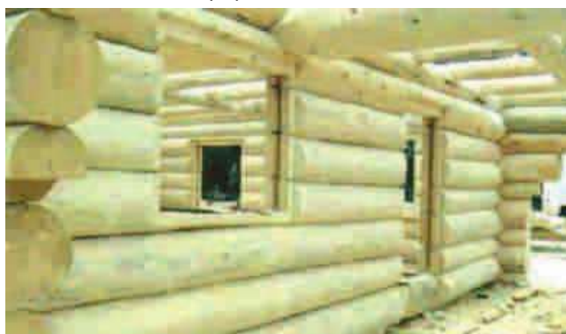
Fig. 66, Vivienda construida con troncos macizos, de diámetro promedio de 30 a 35 cm. Fuente, "La Construcción de Viviendas en Madera", p. 122
