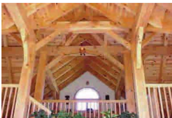
Fig. 70, Vigas, pilares y elementos estructurales a la vista en interior. Fuente, “La Construcción de Viviendas en Madera”, p. 124
