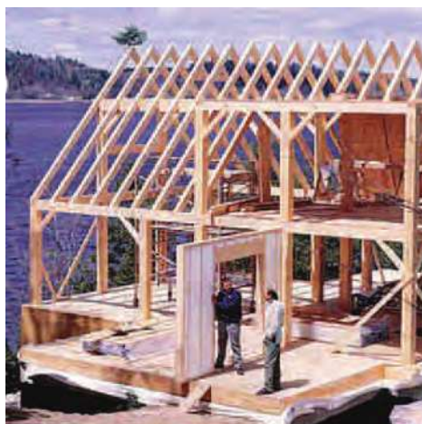
Fig. 69, Vigas horizontales e inclinadas, transmitiendo esfuerzos a pilares o columnas. Fuente, “La Construcción de Viviendas en Madera”, p. 124
