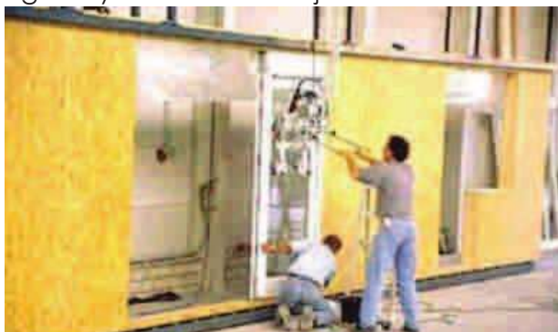
Fig. 67, Instalación de puerta en tablero autosoportantes. Fuente, "La Construcción de Viviendas en Madera", p. 123
