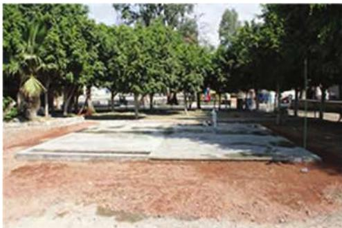
Losa lista y preparada con las salidas de las instalaciones del drenaje
