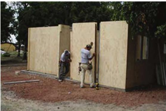
Se terminan de colocar los paneles exteriores para ir cerrando los espacios y continuar con las aberturas de ventanas y puertas.
