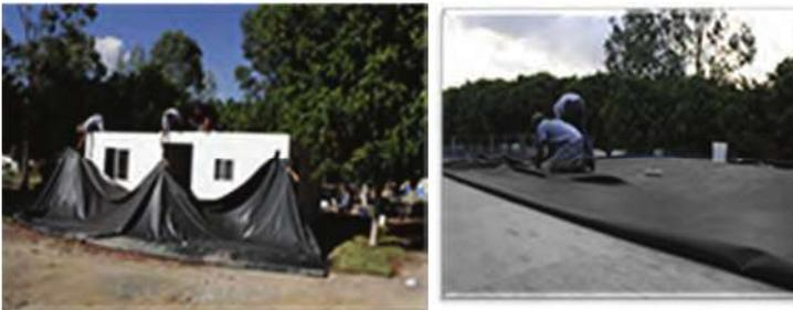
Para el impermeabilizante se recomienda una membrana o bien un prefabricado esto para dar mejor seguridad en cuanto a las filtraciones de agua (goteras).
