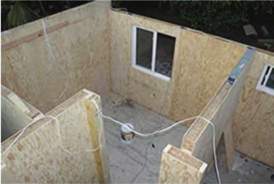
Ensamble de muros internos de acuerdo al plano de construcción.
