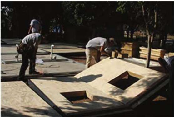
Se ensambla el panel UNITECH al canal en forma manual.
