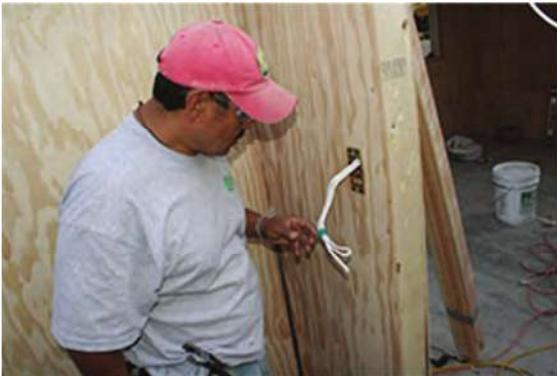
Se marcan dónde van las salidas de los apagadores y contactos y se perfora solo la medida de las tapas esto para no dejar ranuras visibles que puedan ser notables.
