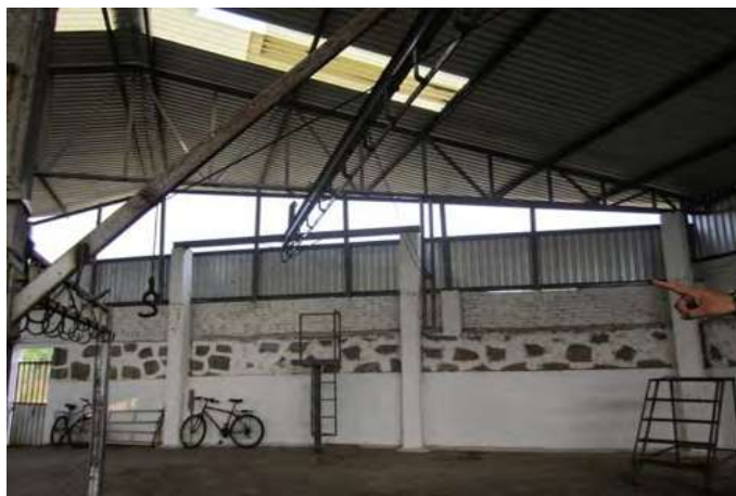
Figura N.43.fotografía del área de corte de canal y lavado
