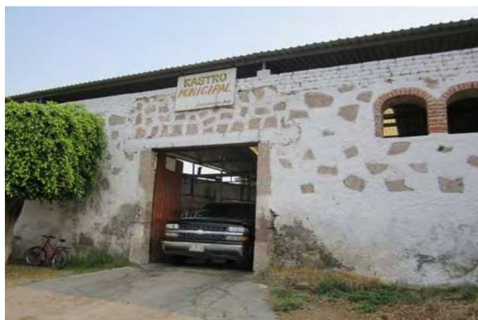
Figura N.36. fotografía del área de acceso del rastro/JDRD. corrales/JDRD.
