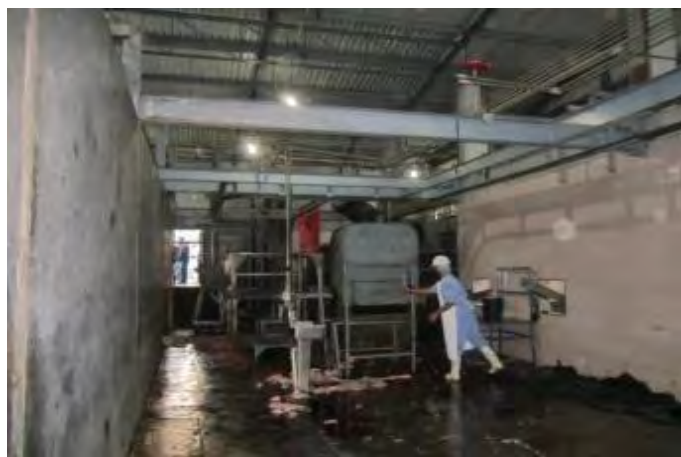
Figura N.24. Fotografía del área de calderas, Depiladora, retiro de vísceras y rieles/JDRD
