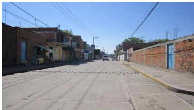
Figura N.84.fotografía Av. José Ma. Morelos Ote. Salida a Acambaro Gto/JDRD
