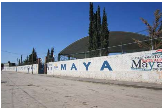
Figura N.79.fotografía Unidad deportiva de Santa Ana Maya /JDRD
