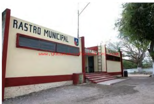
Figura N 7.imagen de la fachada del rastro municipal, municipio de Umán, Yucatán México
