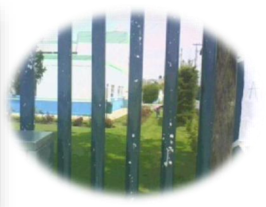
Imagen 58: Vista exterior del Centro de salud.
