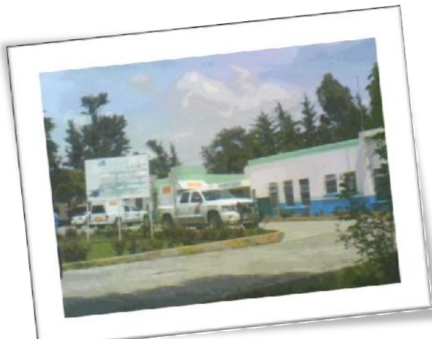
Imagen 55. Fachada principal del hospital Balbuena
