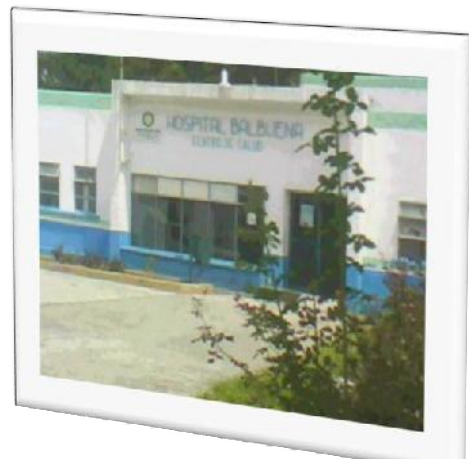
Imagen 56: Fachada principal del Hospital balbuena
