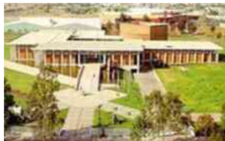
Fig.021. vista del Acceso principal al recinto [www.02de51a.netsolhost.com/abril 05, 2010]
