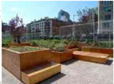
Banco de longitud variable formada con concreto recubierta de madera tropical de 0.04 x 0.05 m tratada especialmente para uso en exteriores.
