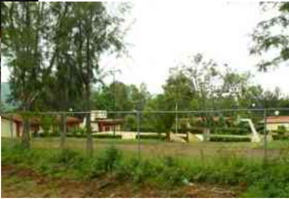
Foto 12. Equipamiento Urbano, Escuela Secundaria Autor: Juan José Bucio Fuerte Fecha: 12/10/2012
