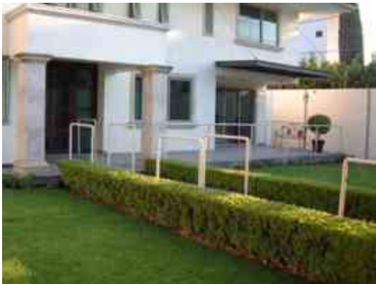
Imagen 3. "La Residencia" para personas de la tercera edad, en Celaya, Guanajuato.
