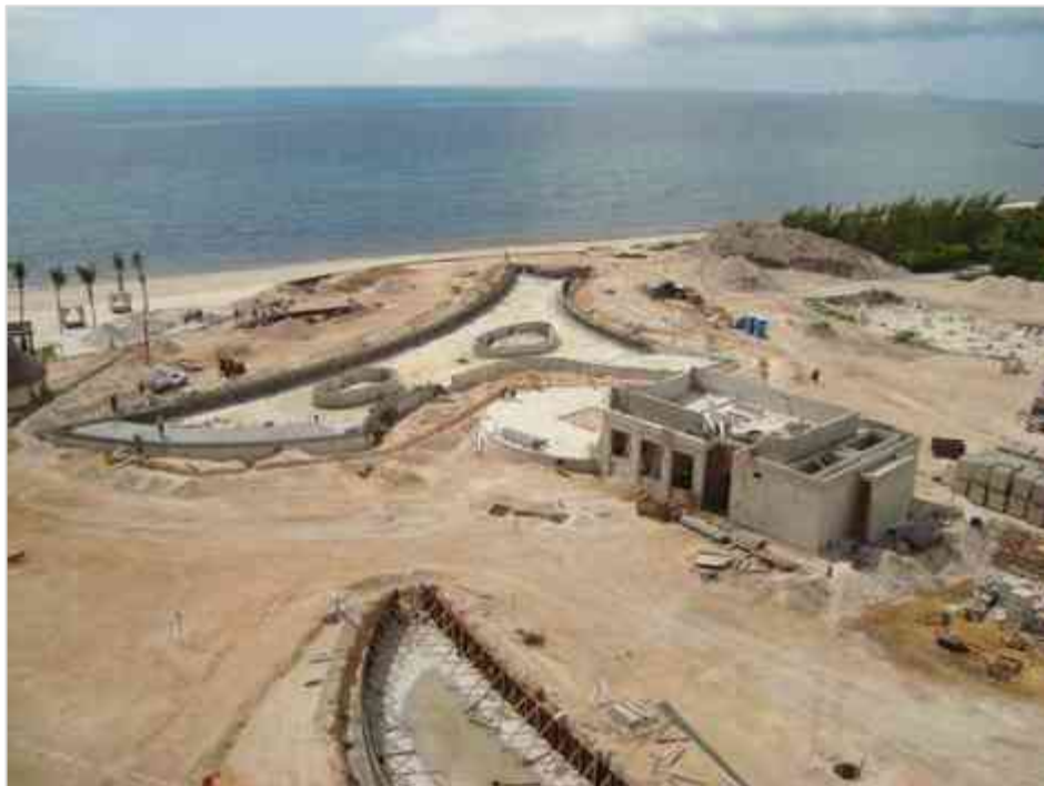
Imagen 93 Construcción de Pretiles en azotea
