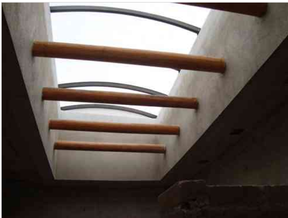
Imagen 113 Colocación de Plafón y Morillos en Área de domo de Sanitarios.
