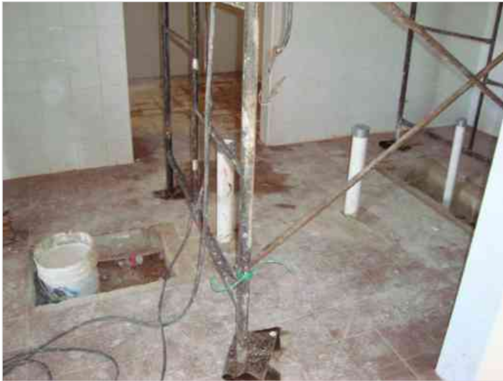
Imagen 96 Colocación de Pisos y Lambrines en interior de cocina.
