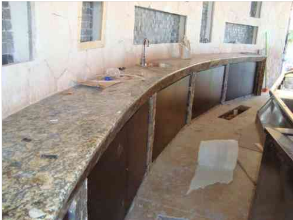
Imagen 133 Colocación de cubiertas de granito en contrabarra y puertas de madera.
