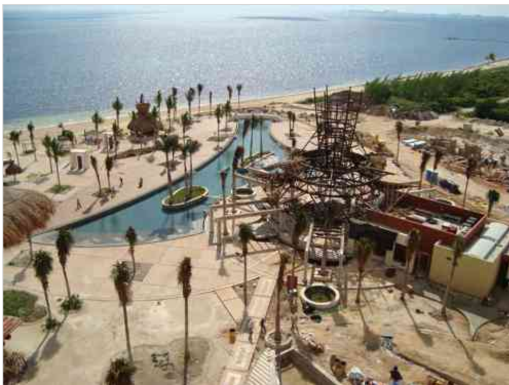
Imagen 123 Colocación de palapa sobre estructura metálica.
