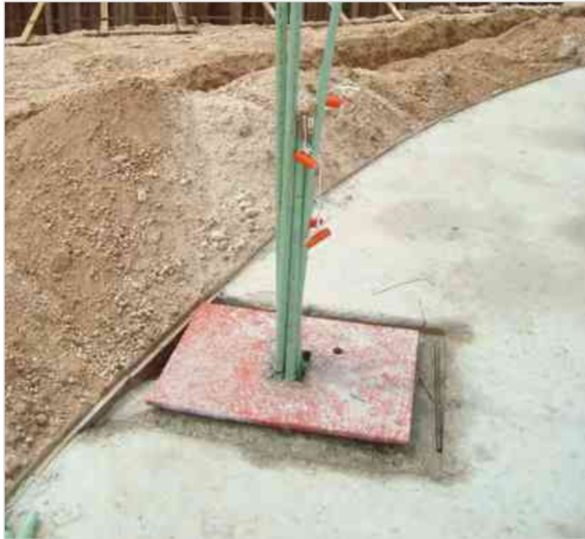
Imagen 90 Preparación Eléctrica en Área de Columnas Metálicas.
