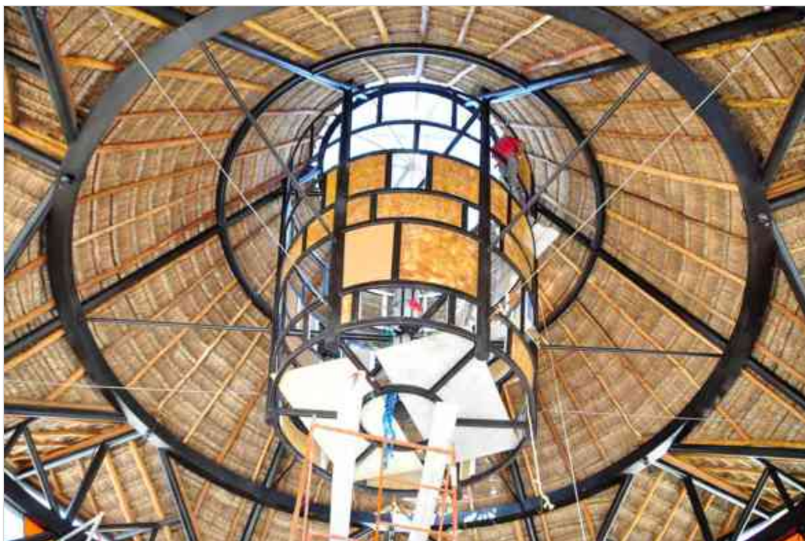
Imagen 131 Colocación de Fibra de Vidrio, imitación ónix, y elementos de tela, por la empresa Tarengo.
