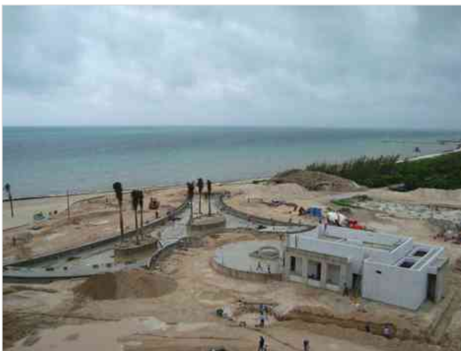
Imagen 95 Aplicación de Sellador en Muros exteriores para recibir pintura.
