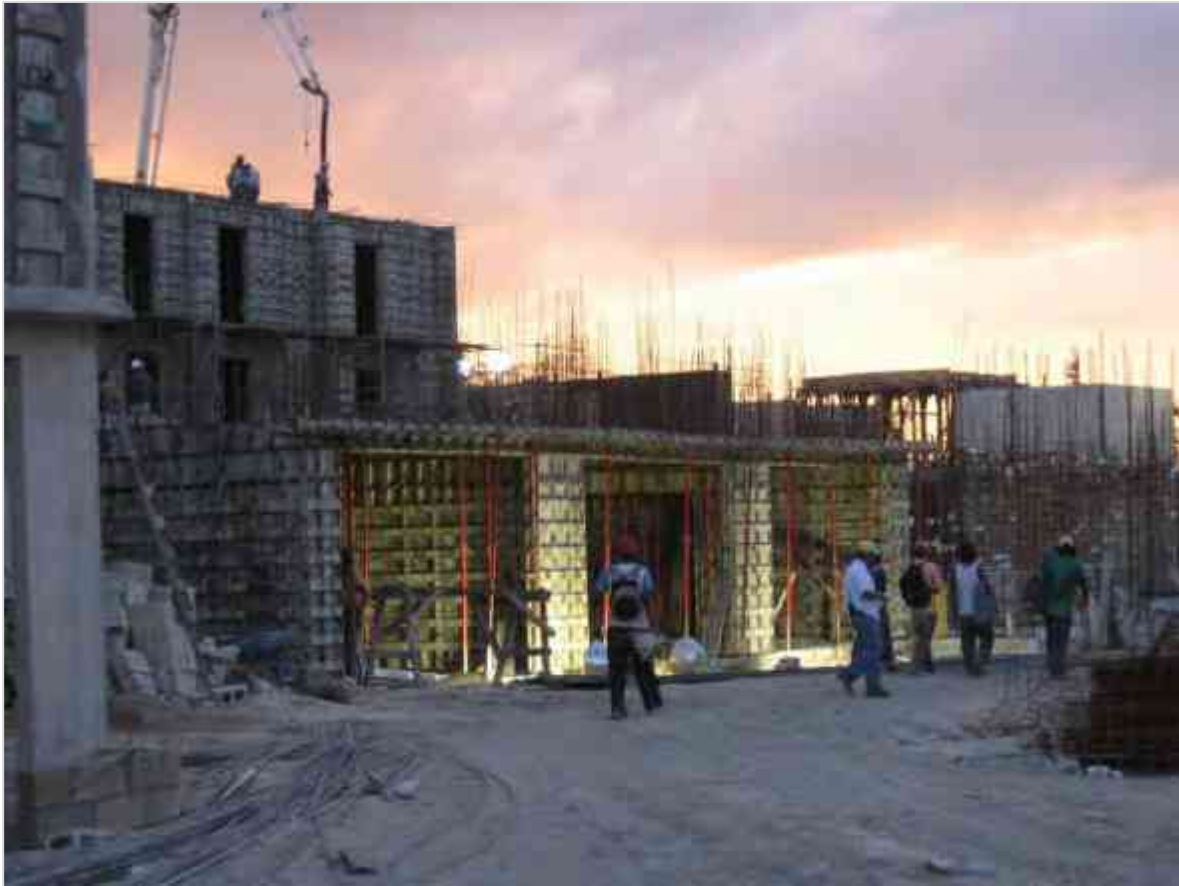
Imagen 11 Sistema de Moldes metálicos para colado de Muros y losa
