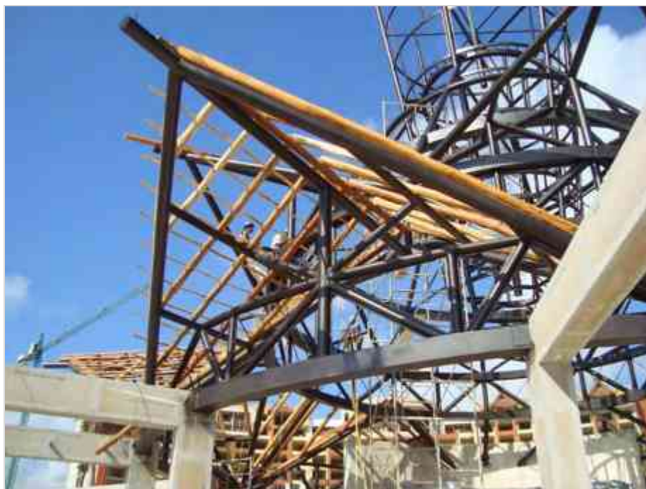
Imagen 122 Colocación de cargadores y giles para instalación de palapa.
