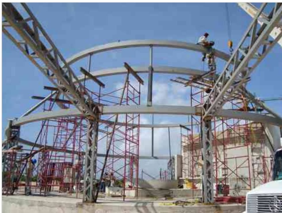
Imagen 98 Armado de Palapa Metálica por parte de la empresa METALTEC S.A. de C.V.
