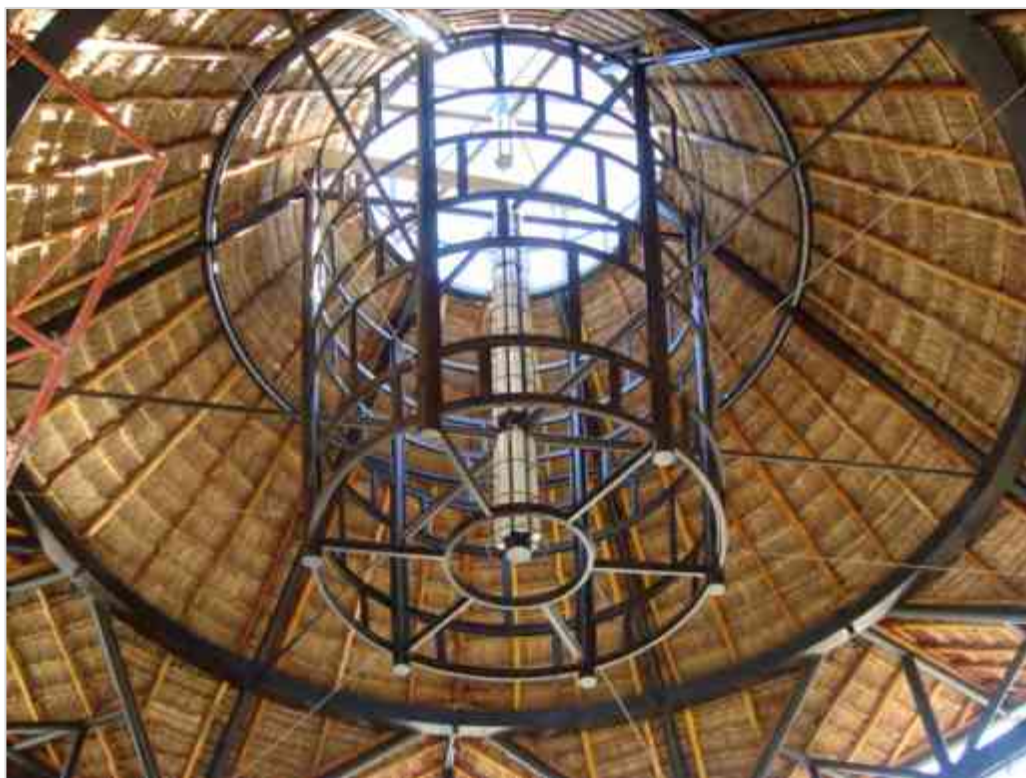
Imagen 129 Instalación de Luminarias en Cono de luz.
