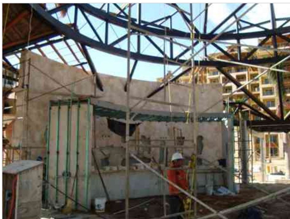
Imagen 125 Colocación de acabados en contrabarra con piedra prefabricada y preparación de Barra para recibir Alubond.
