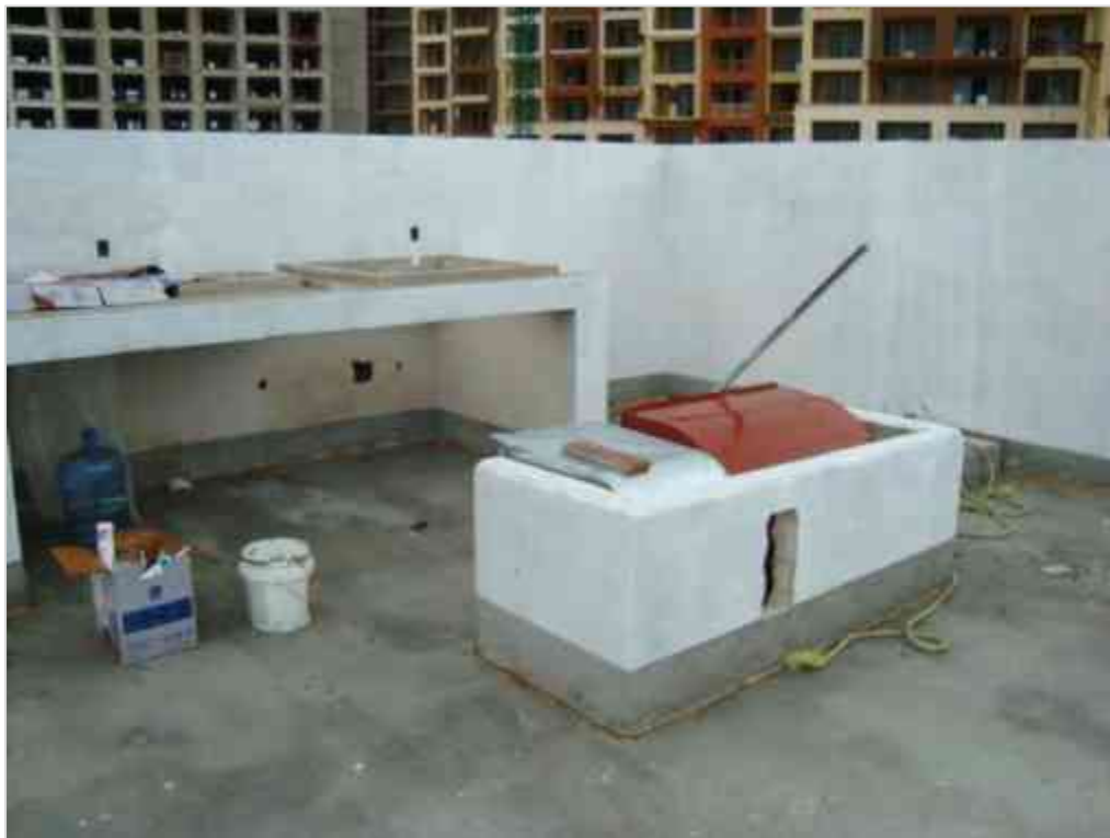
Imagen 97 Colocación de Ductos de sistema de Extracción de Aire.
