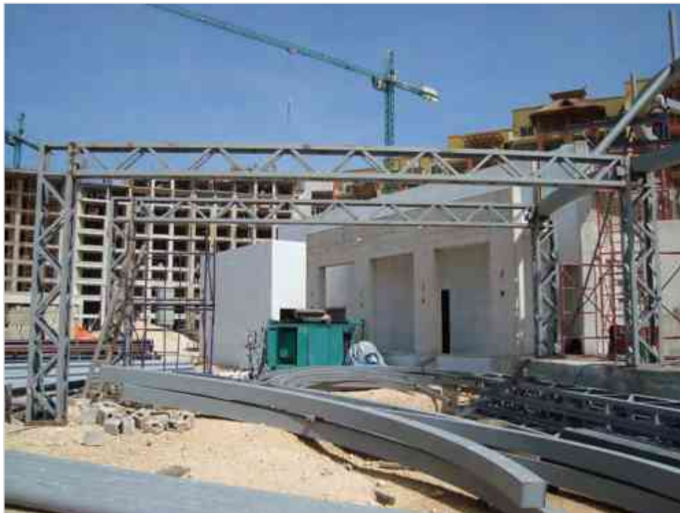
Imagen 99 Armado de Columnas y trabes exteriores de Palapa.
