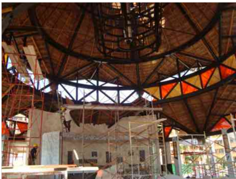
Imagen 130 Colocación de Cristales en perímetro inferior y superior, por la empresa Tarengo.
