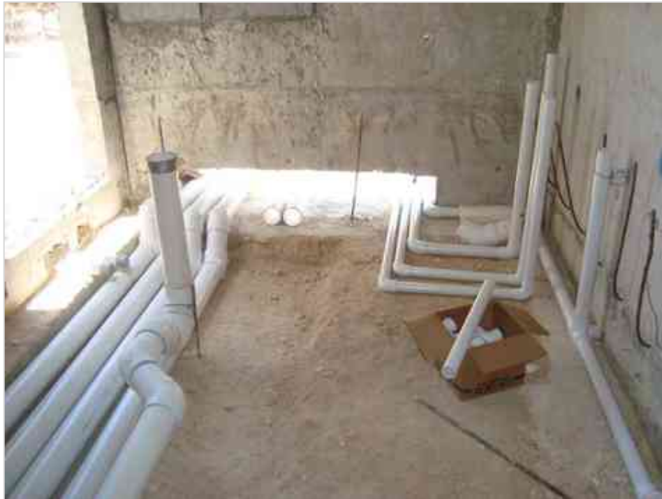
Imagen 92 Habilitado de Tuberías para cuarto de máquinas.
