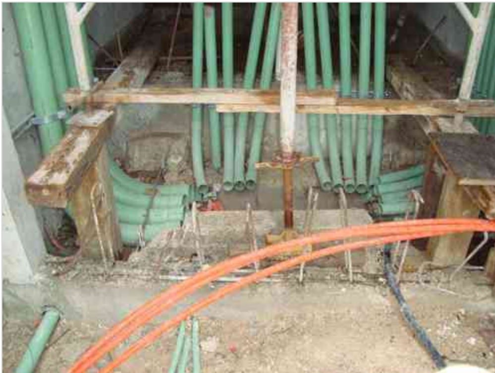
Imagen 89 Preparación de Canalizaciones en Cuarto Eléctrico
