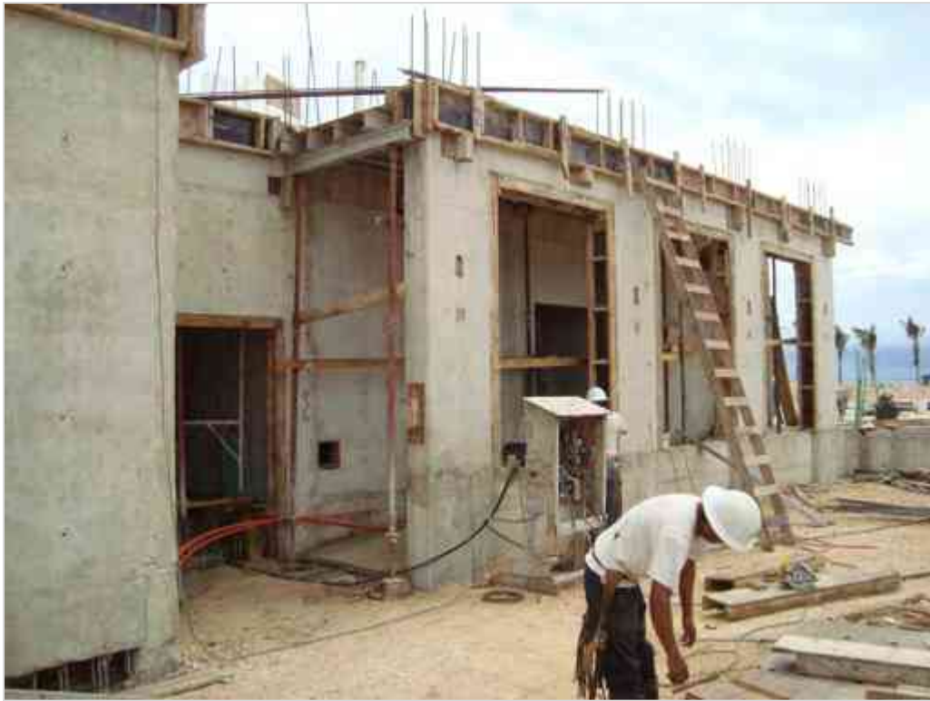
Imagen 88 Preparación para colado de losas.
