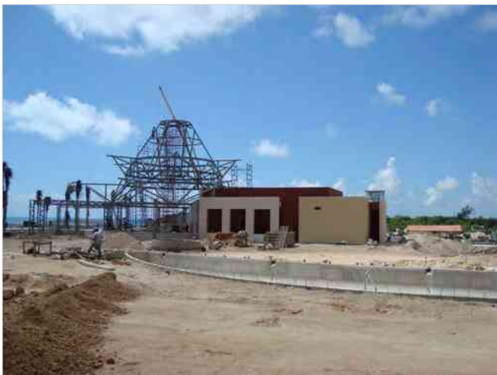
Imagen 107 Aplicación de Pintura en Fachadas exteriores.
