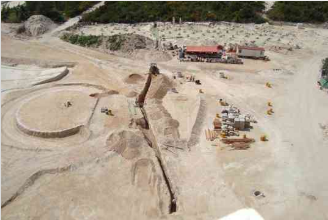
Imagen 82 Excavación de trincheras para paso de instalaciones.
