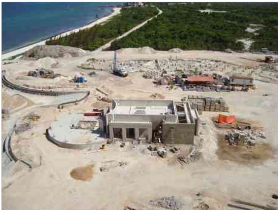
Imagen 94 Comienzo de Aplanados en Muros.
