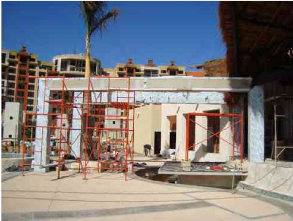
Imagen 126 Colocación de Alubond en columnas exteriores.
