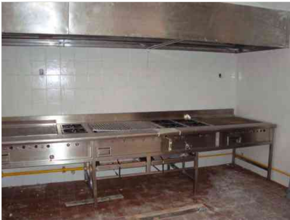
Imagen 115 Colocación de Tren de Cocción en Área de Cocina.
