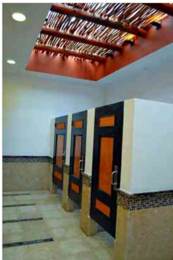
Imagen 136 Colocación de Carpintería en sanitarios.
