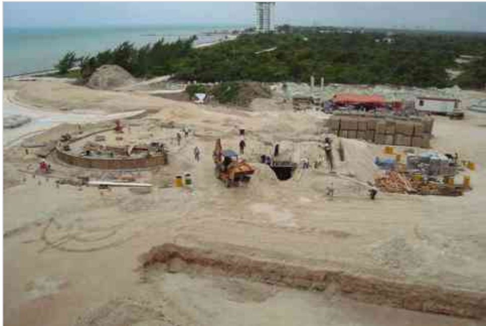
Imagen 84 Colado de Muro de Contención en Espejo de agua, así como colado de cárcamo de aguas negras y plantillas para muros en área de servicios.
