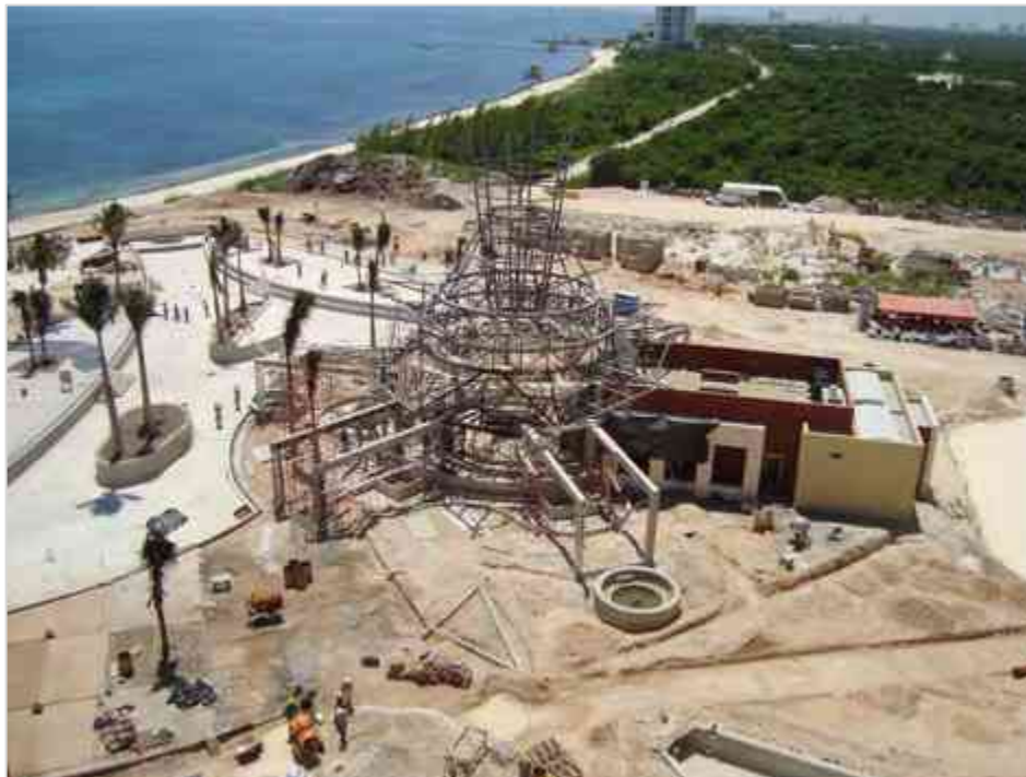
Imagen 114 Sandblasteo en palapa metálica para retirar oxido, y aplicación de Primer y Pintura.
