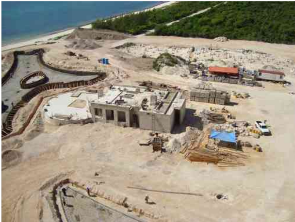
Imagen 91 Colado de Losas terminado y habilitado de bases de concreto para equipos en azotea.
