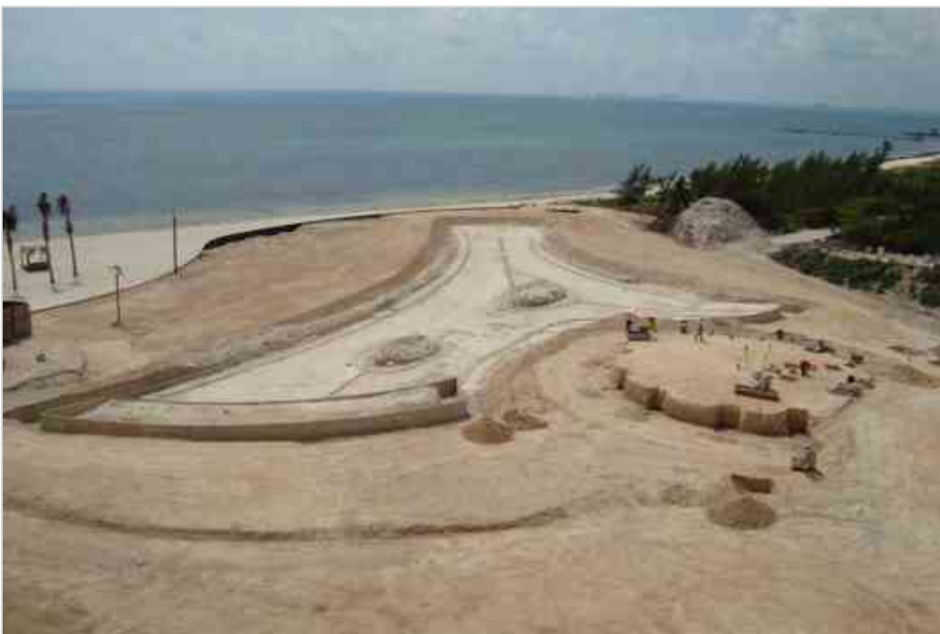
Imagen 83 Colado de Plantillas para cimentación de Estructura metálica.
