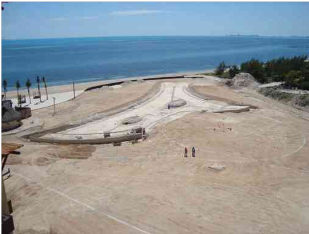
Imagen 80 Trazo de Ejes para continuar con forjado y compactación de terracerías.
