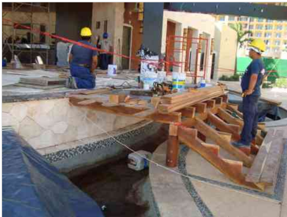
Imagen 132 Construcción de Puente de Acceso de Madera Tzalam.
