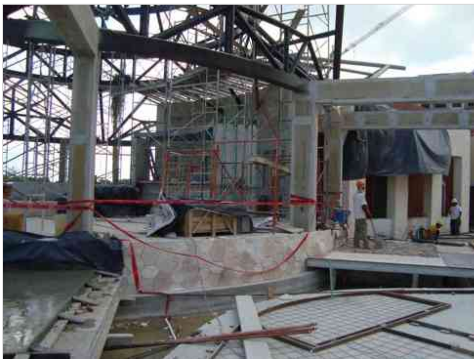
Imagen 118 Colocación de acabados en espejo de agua, y forrado con durock de columnas exteriores.
