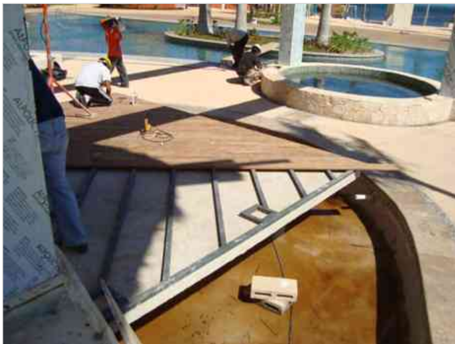
Imagen 127 Colocación de Duela de Madera en área de terraza.
