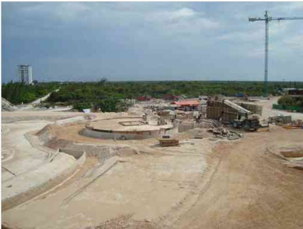
Imagen 85 Habilitado de Tableros, para colado de muros de concreto, y compactación de terracería en espejo de agua.
