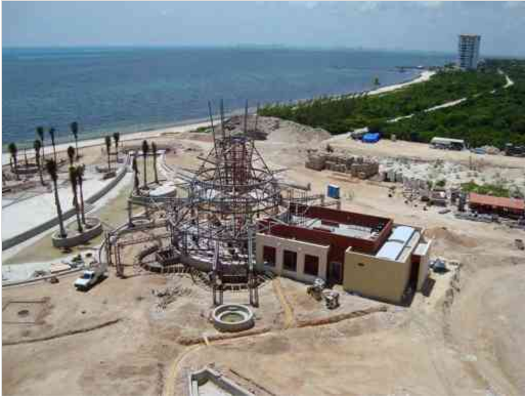
Imagen 108 Habilitado de Cimbra para espejo de agua, y Armado de Cono de luz en palapa Metalica.
