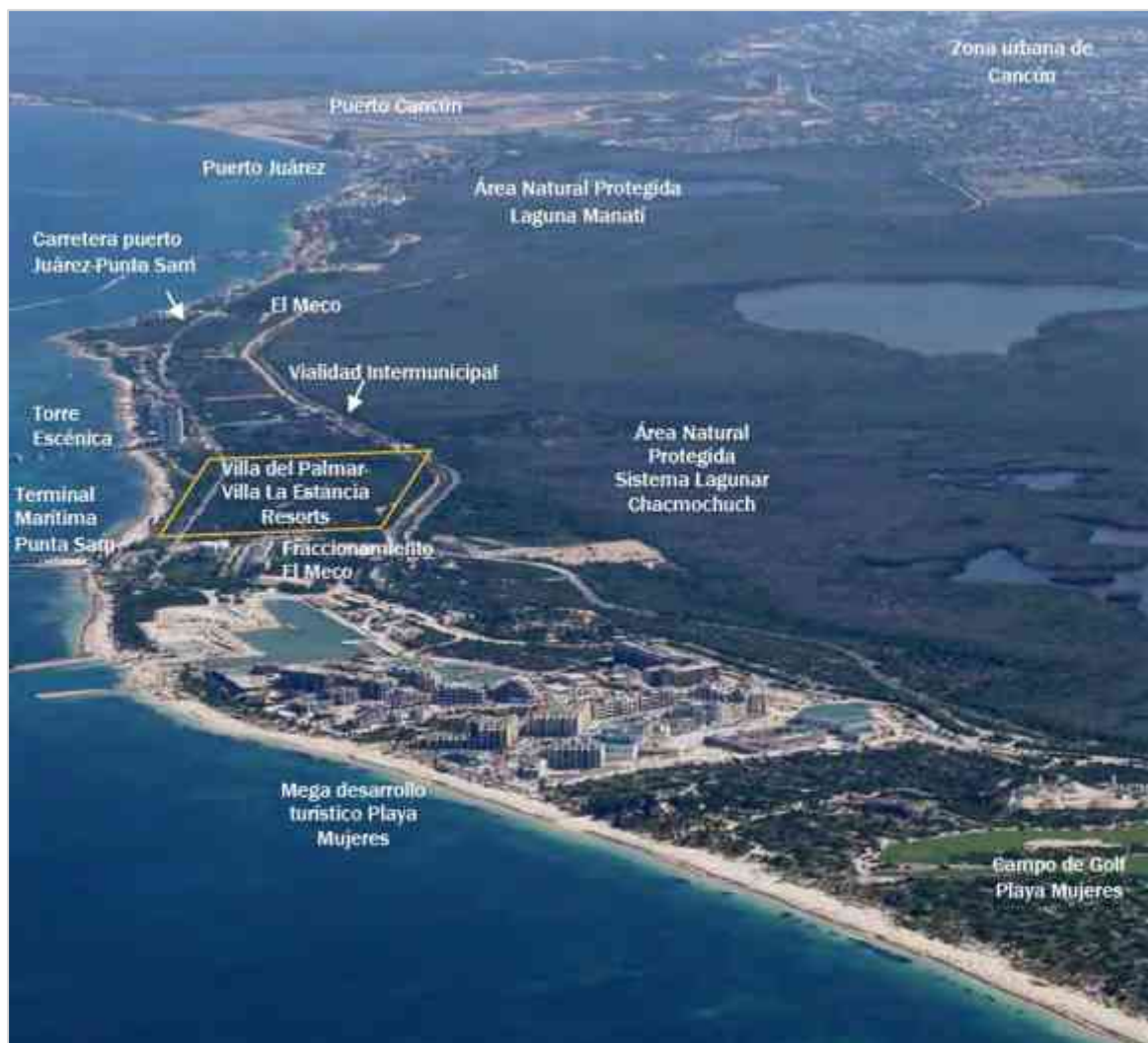
Imagen 40 (Vista área de la ubicación del predio, realizada por la empresa SYLVATICA, S.C.)
