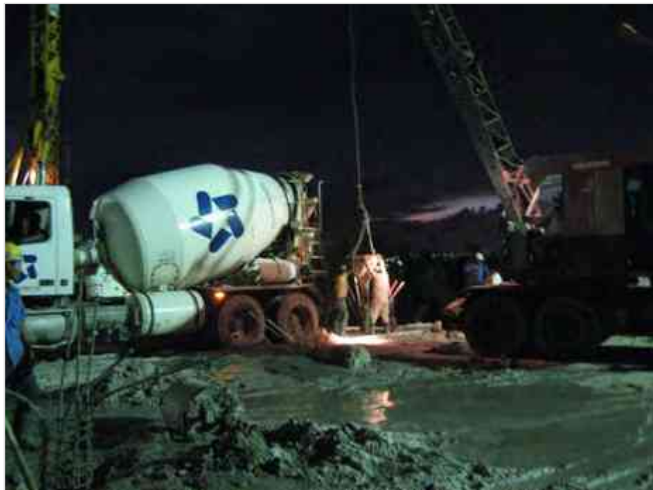
Imagen 12 colado de Pilotes de cimentación
