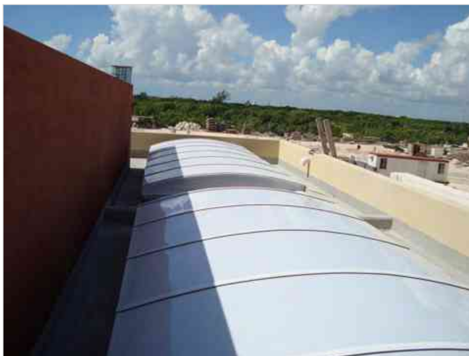
Imagen 105 Colocación de Domos de acrílico en área de sanitarios.
