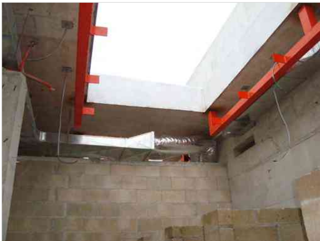
Imagen 101 Colocación de Ductos en área de Sanitarios. Y estructura metálica para morillos en domo.
