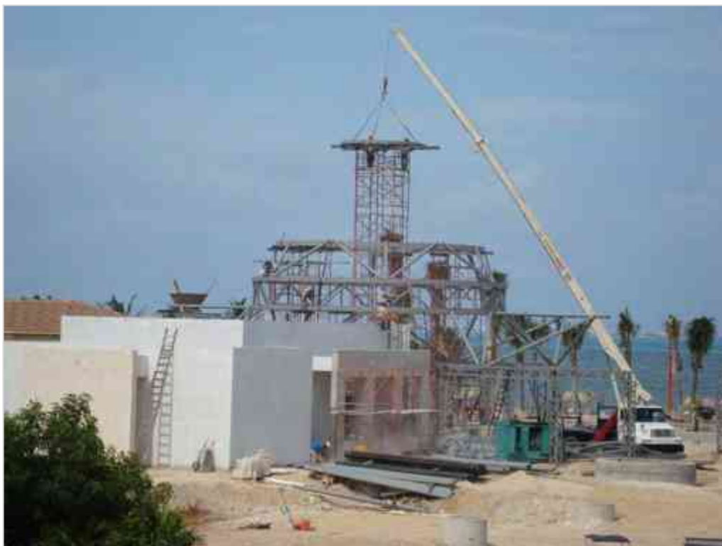
Imagen 103 Continuación de Armado de Palapa Metálica, en sus últimos niveles.
