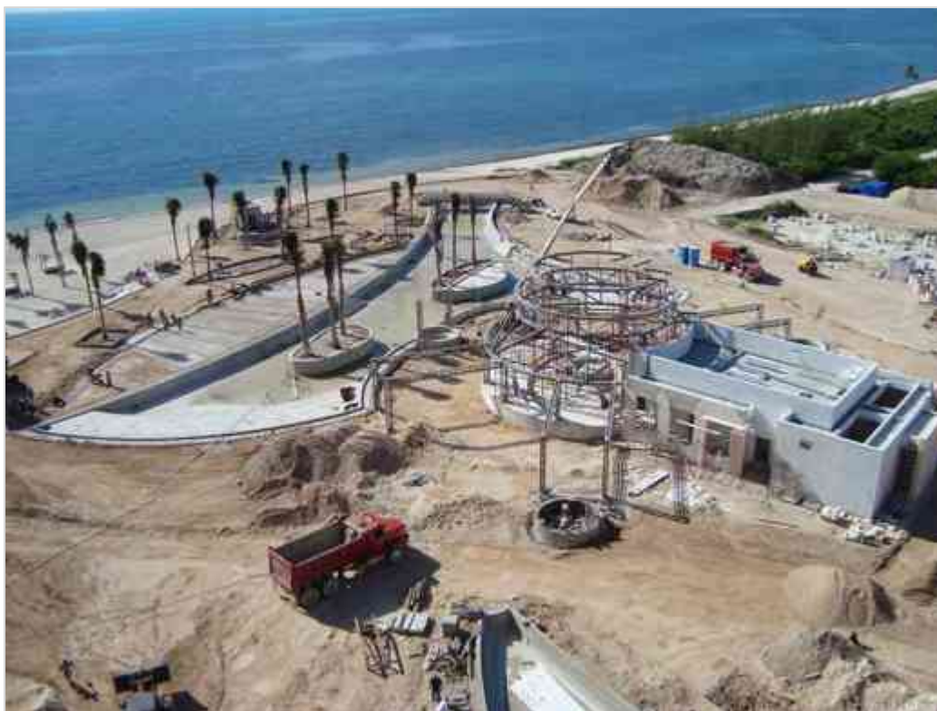
Imagen 100 Habilitado de Andamios para colocación de estructura Metálica.
