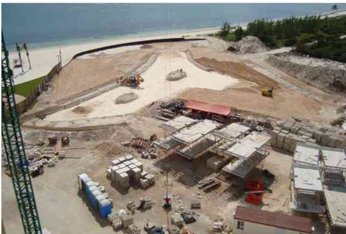
Imagen 79 Inicio de compactación de terracerías.
