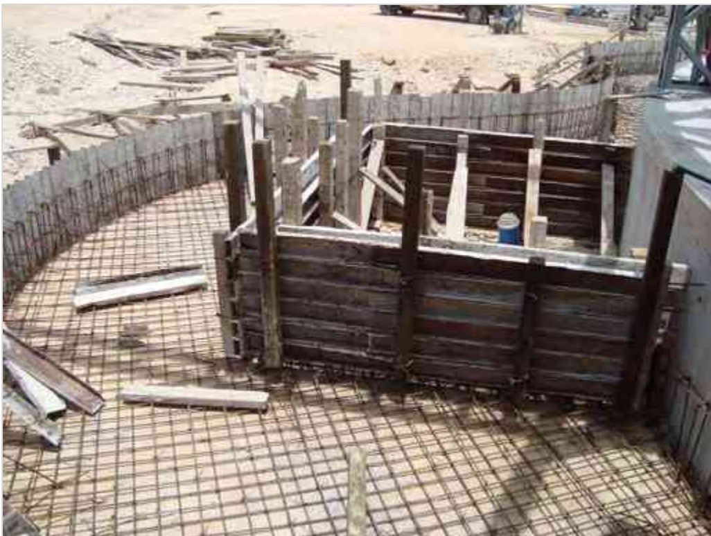
Imagen 109 Habilitado de Cimbra para espejo de agua y terrazas.
