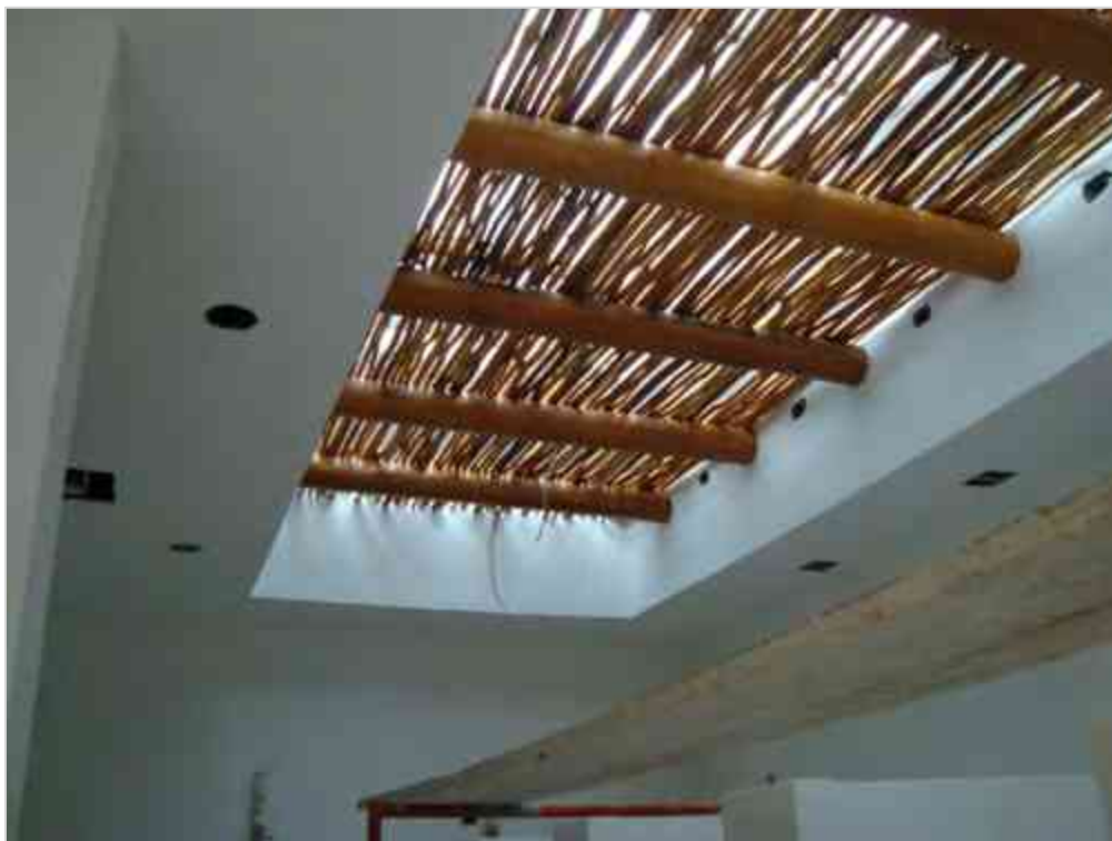
Imagen 120 Colocación de giles en área de sanitarios para cubrir vista hacia domo de acrílico.
