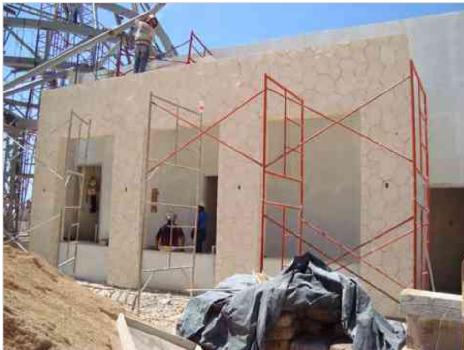
Imagen 104 Colocación de Acabados en Muros exteriores, Piedra prefabricada imitación piedra Maya.
