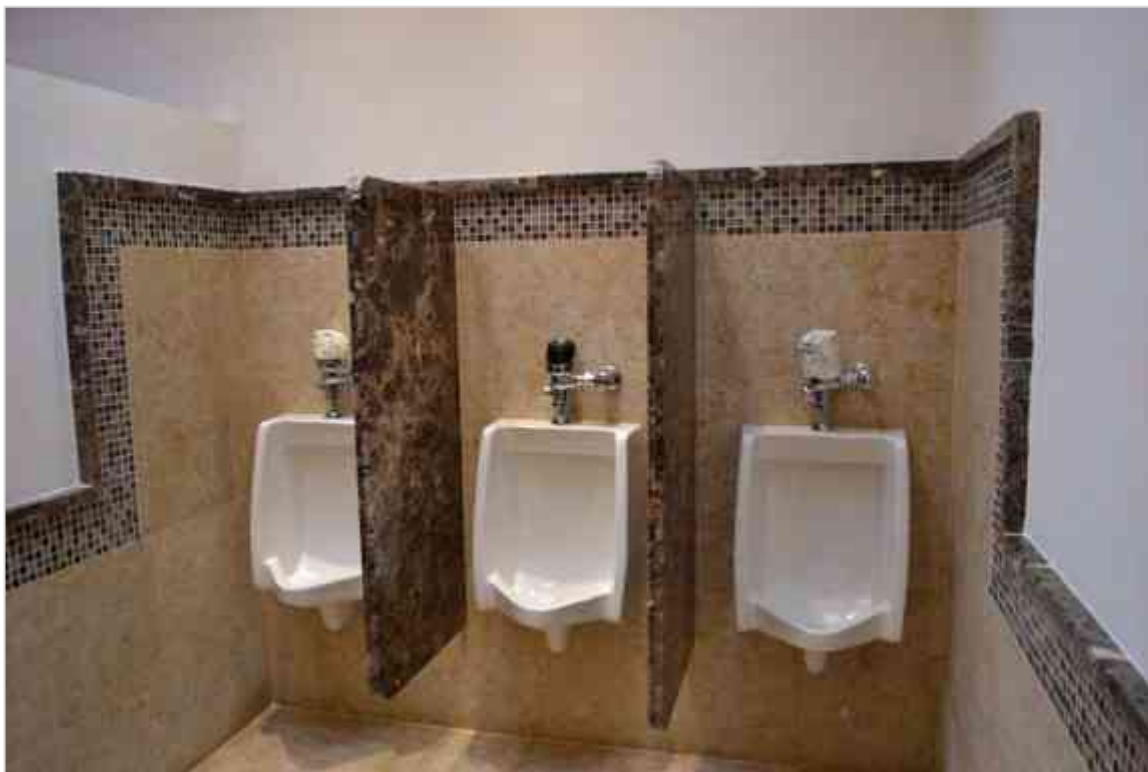
Imagen 134 Colocación de acabados y equipamiento en sanitarios.
