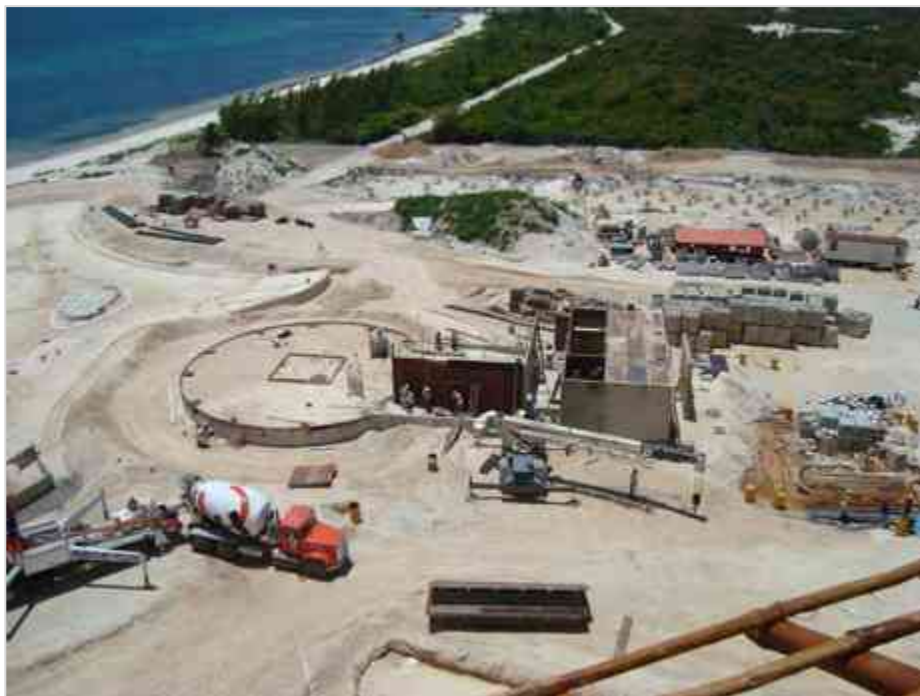
Imagen 86 Habilitado de Placas para columnas metálicas, y Colado de Muros de Concreto.
