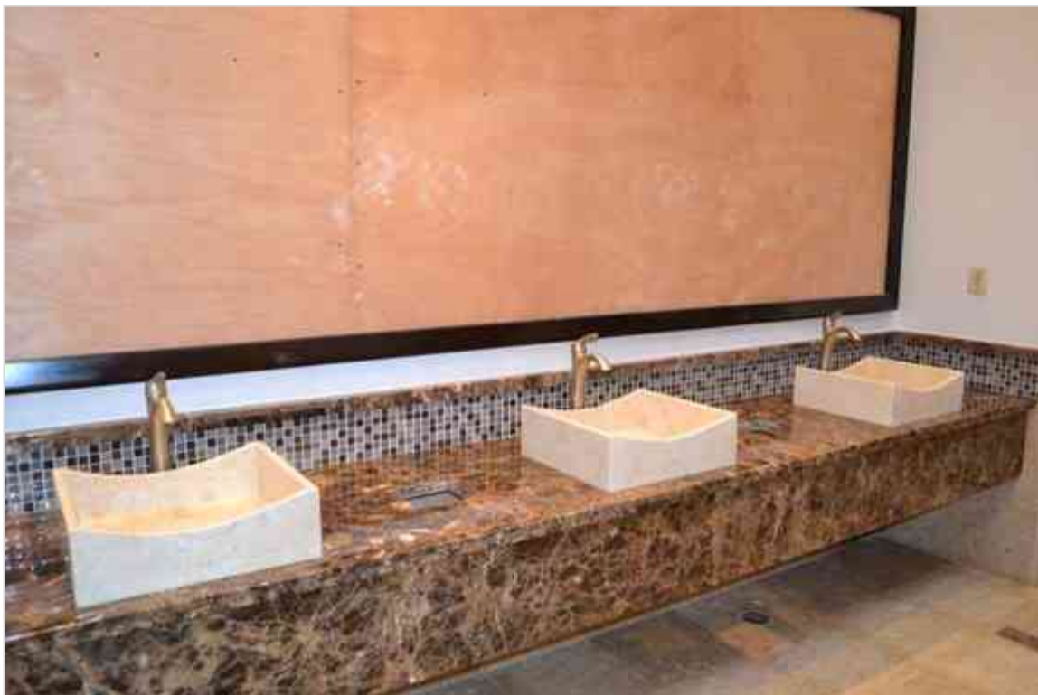
Imagen 135 Colocación de acabados y cubierta de mármol en lavamanos de sanitarios.
