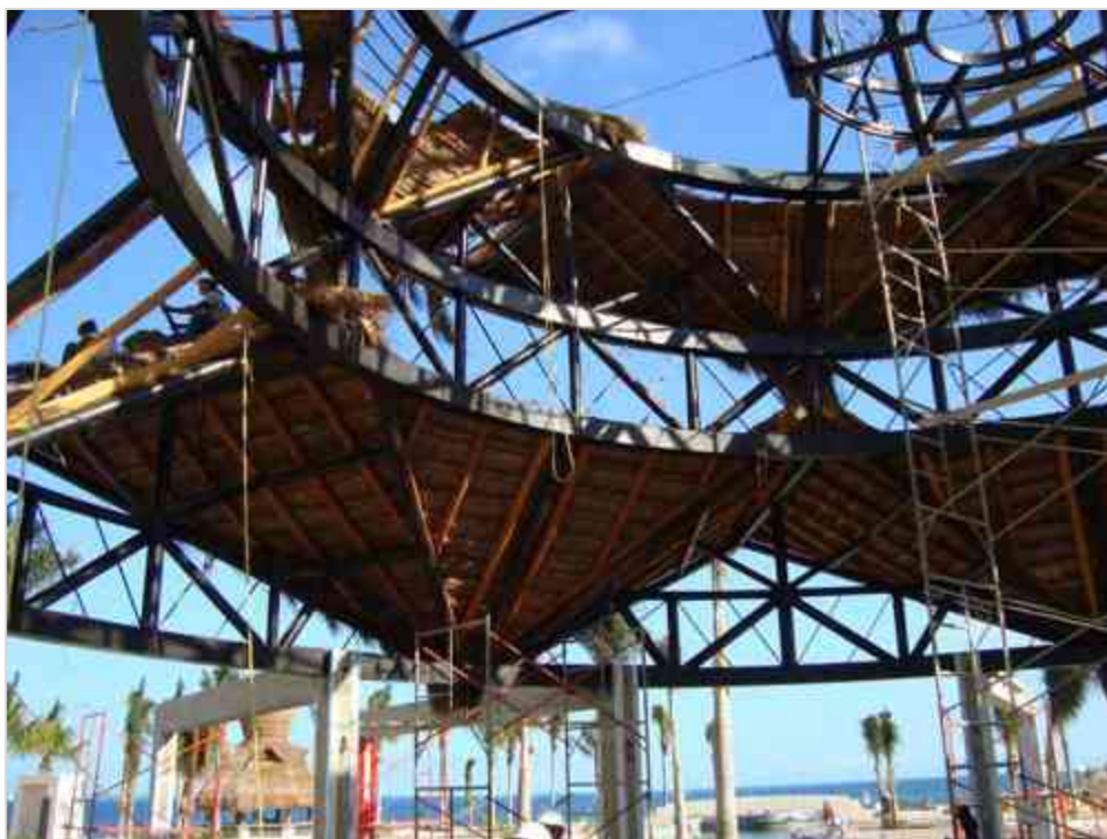
Imagen 124 Vista de la colocación de la palapa desde el interior.
