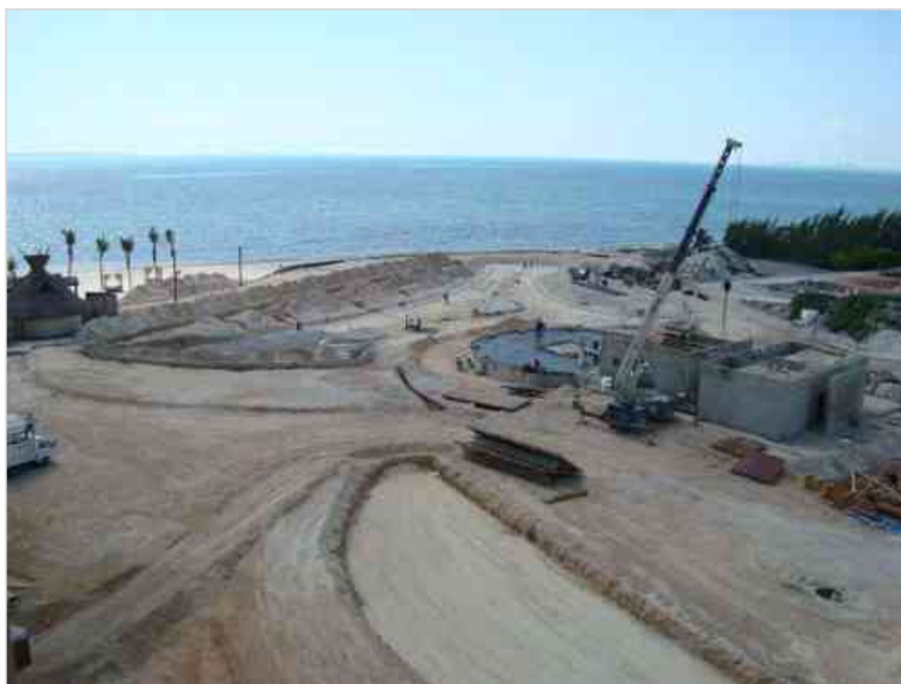
Imagen 87 Habilitado de Varilla para Colado de Firme en Área de Palapa y Colado de Muros de Concreto.
