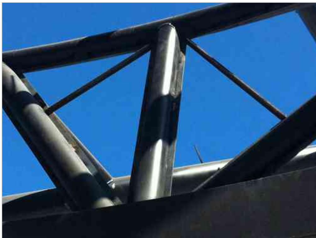
Imagen 119 Colocación de ángulos para instalación de cristales en perímetro de palapa.
