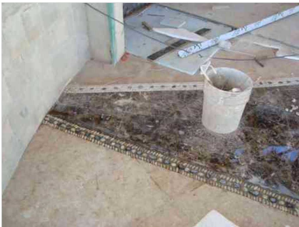
Imagen 128 Colocación de cenefas especiales y pisos en área de comensales.
