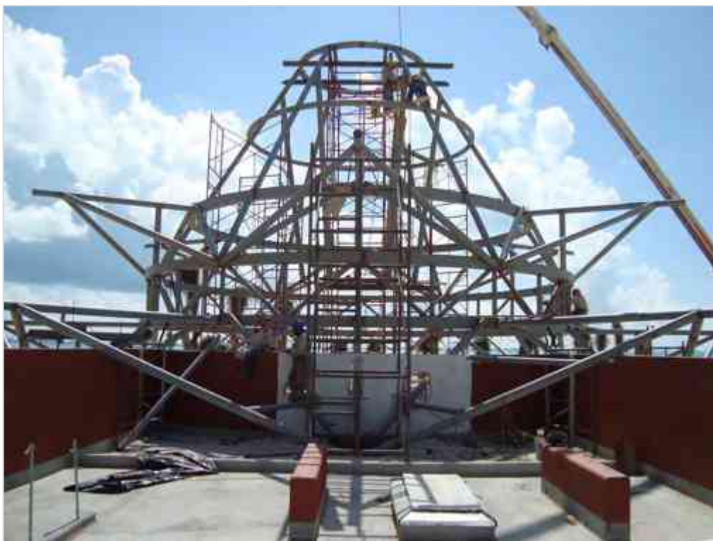
Imagen 106 Fijación de Palapa metálica a placas metálicas ahogadas en azotea.
