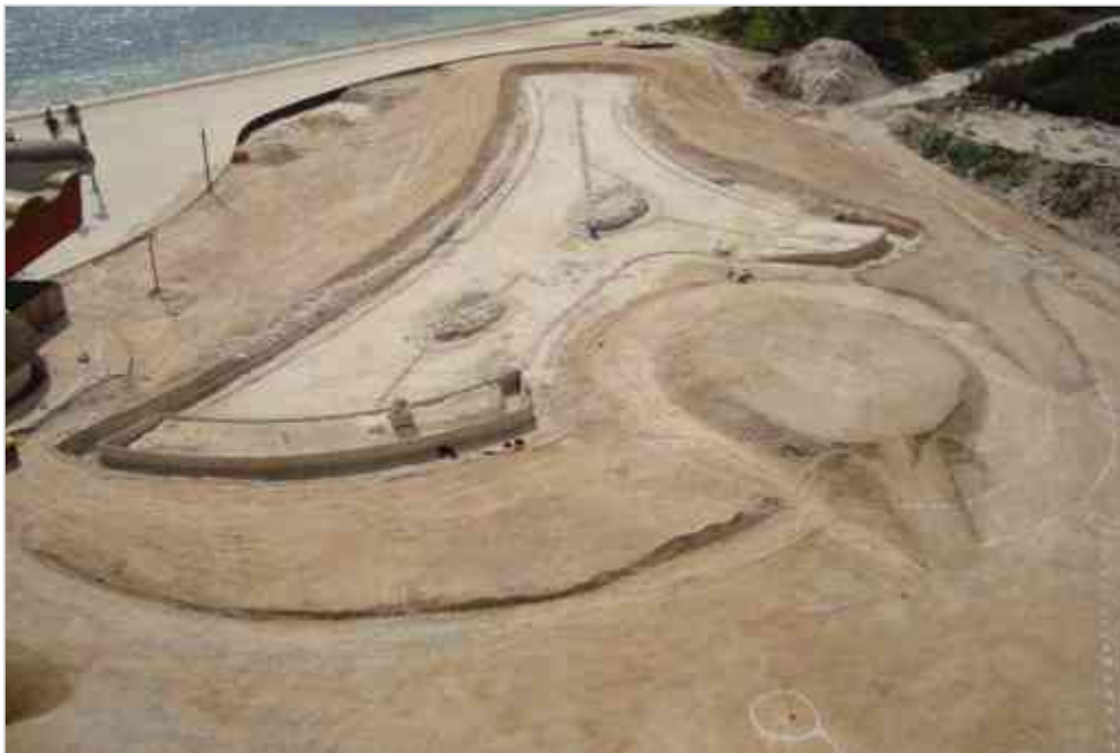
Imagen 81 Compactación de terracerías en área de Palapa.
