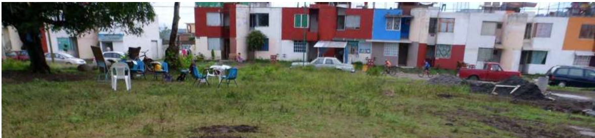
Fotografía 6.- Estilo y estado actual del conjunto habitacional Valle real, frente al terreno L.R.Silva fotografía
