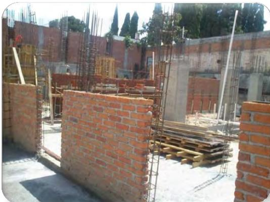
**Foto 39.- Muros de tabique y columnas de hormigón. Por S.I.A.S.**
