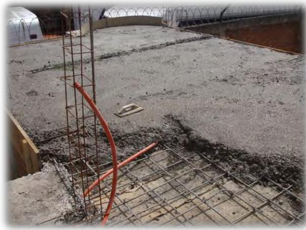
Imagen 39. Armado y colado de una losa maciza. (Foto por Ruth Herrera Barriga.)
