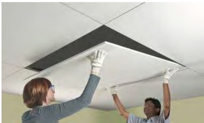
Fig. 46.- Aplicación del panel para plafón.
