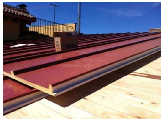
Fig. 61.- Cubierta de panel sándwich.
