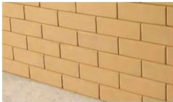
Fig. 40.- Muro de Adobe tecnificado.
