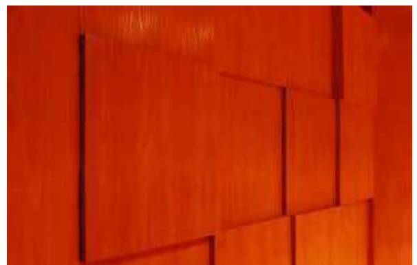
Fig. 47.- Aplicación del cedro en muros.
