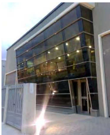
Fig. 41.- Muro de cristal exterior.
