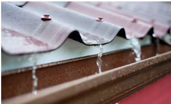
Fig.35.- sistema de captación pluvial.
