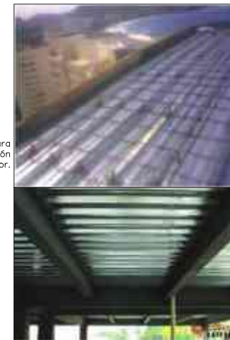
Vista de la losacero ya instalada.
