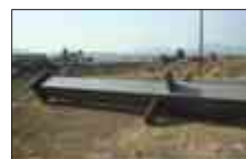
Imagen de columna OR de 10" x 10" con cartabones soldados para recibir vigas.
