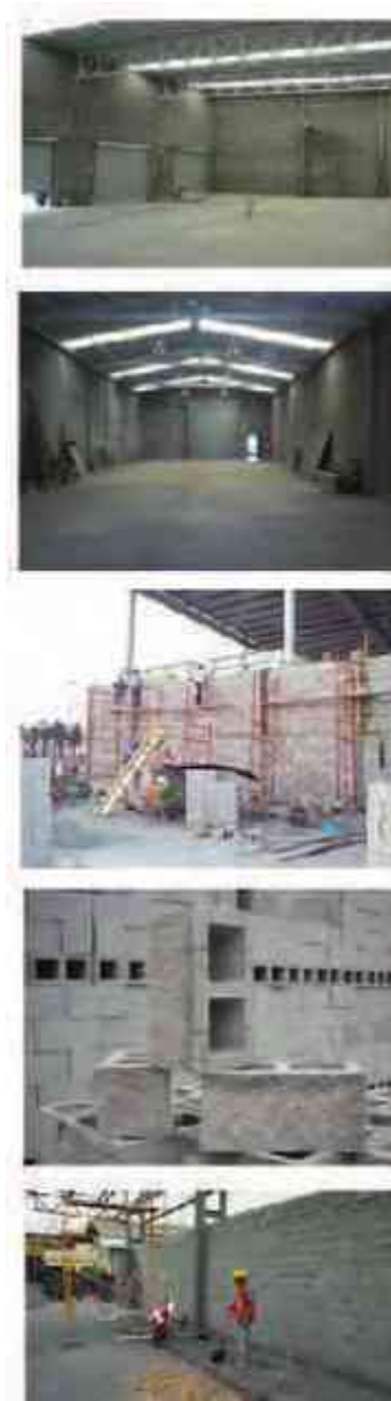
Imágenes 64 a 68.- Imágenes de muros de block de concreto, ligados con cadena de desplante, intermedia y de cerramiento, de concreto armado. 200 kg/cm 2 . blockdelsur.com
