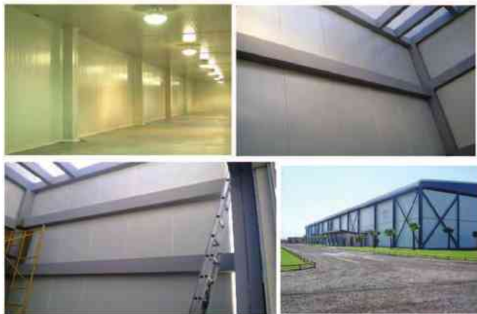
Imágenes 69 a 71.- Imágenes de muros panel metálico en construcción de frigorífico en Puebla. grupoconstruccionesyservicios.com
