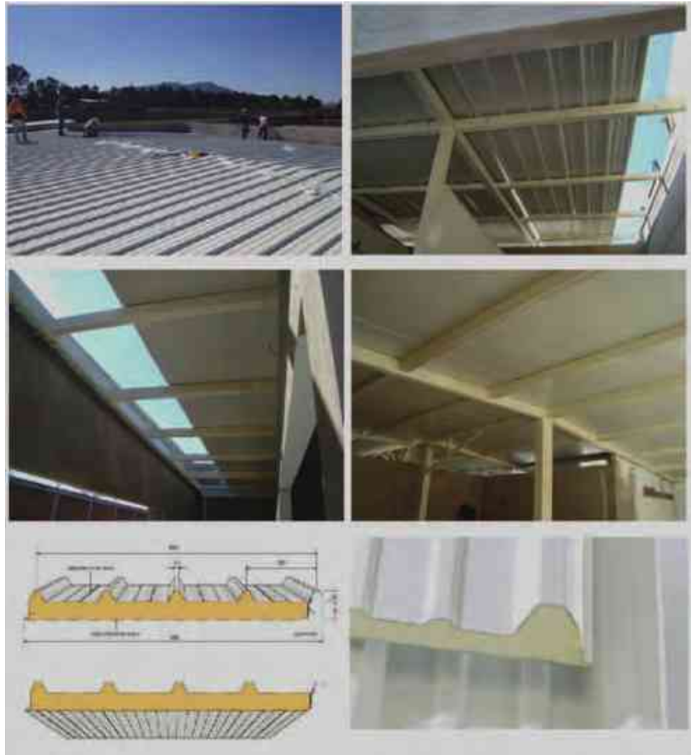
Imágenes 58 a 63. Imágenes de cubiertas de panel metálico. Imágenes 58 a 61 propias. Imágenes 62 y 63 laminas.mx
