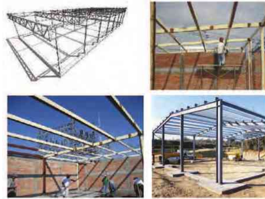
Imágenes 54 a 57. Imágenes de estructuras metálicas. Imágenes 55 y 56 propias. Imágenes 54 y 57 google.com
