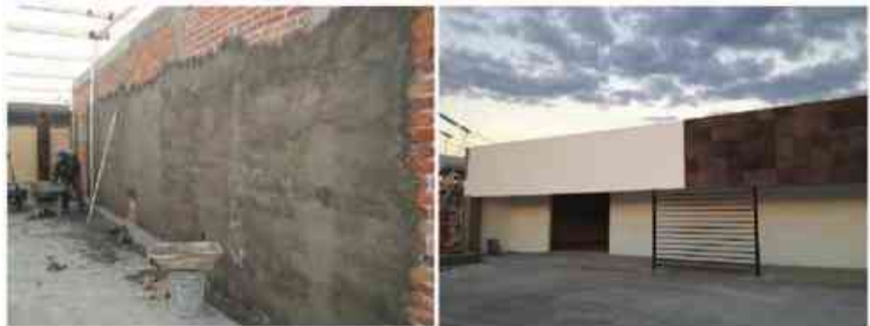
Imágenes 78 y 79. Imágenes de los acabados en muros de las bodegas y de las fachadas y muros de administración. Imágenes propias.
