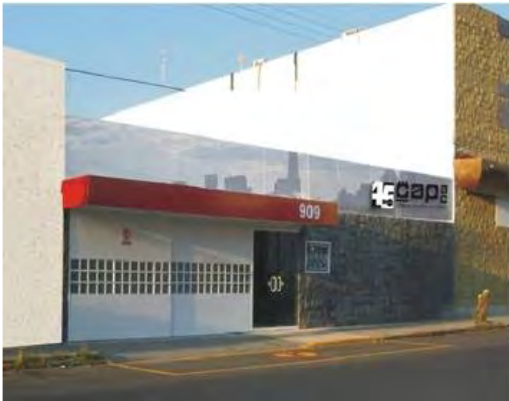
6 Colegio de Arquitectos del Estado de Puebla.
