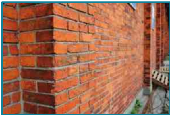
47. Muro de tabique rojo recocado.
