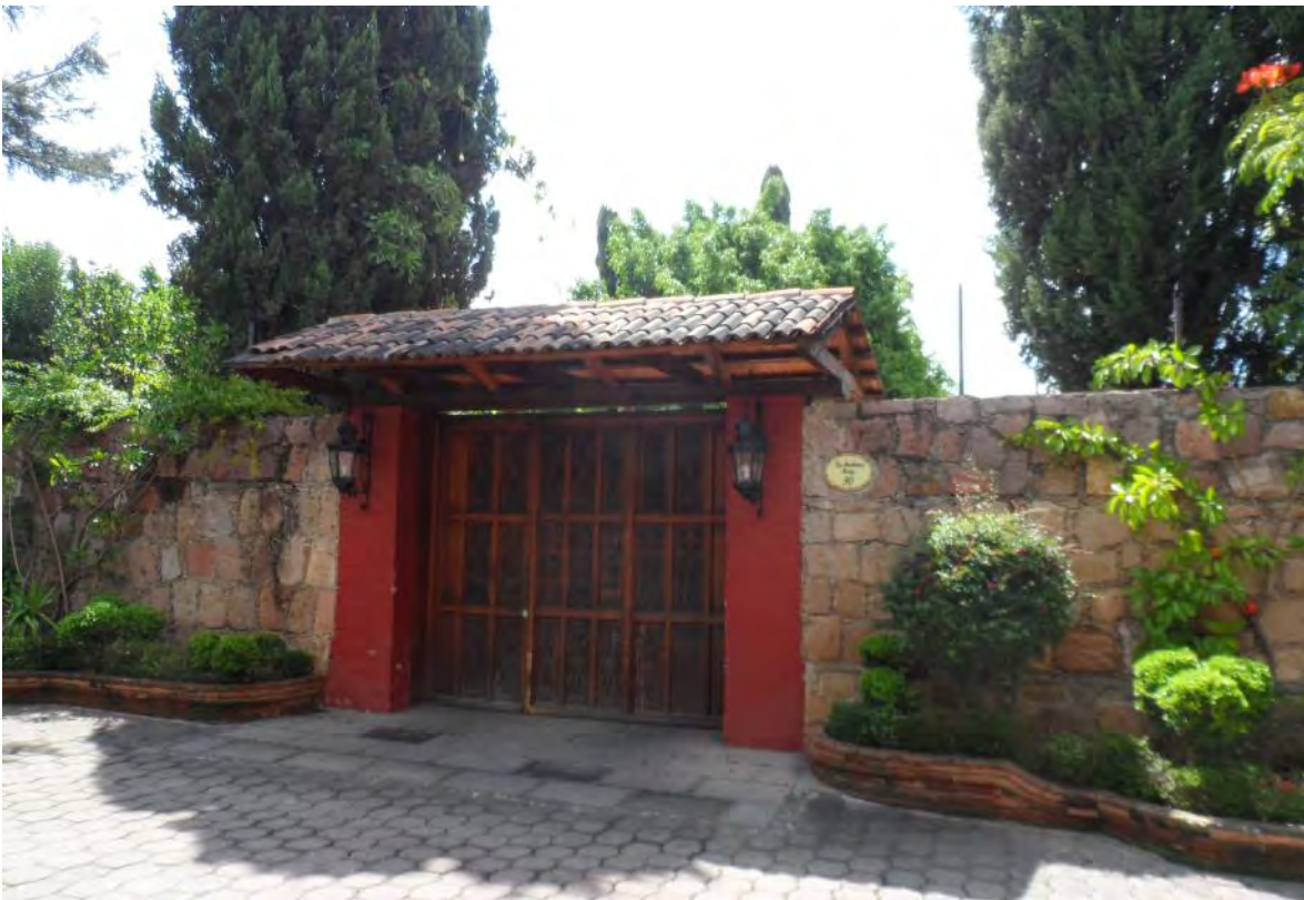
Fotografía 60. Las Morelianas Acceso sobre Calle El Retajo. 2014. Autor: ES. EL.
