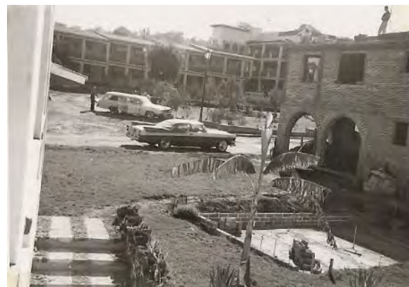
Fotografía 17. Hotel Posada Vista Bella. Durante su construcción. Proporcionada por la Dra. Catherine R. Ettinger.
