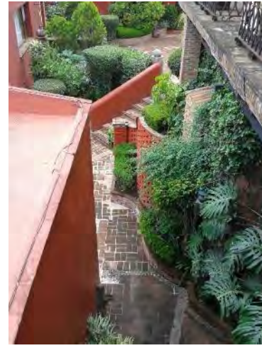
Fotografía 23. Hotel Villa Montaña. Andadores exteriores, 2014. Autor: ES.EL
