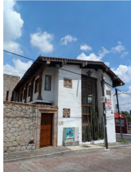
Fotografía 78. Fachada este de la escuela de inglés. Autor: ES.EL
