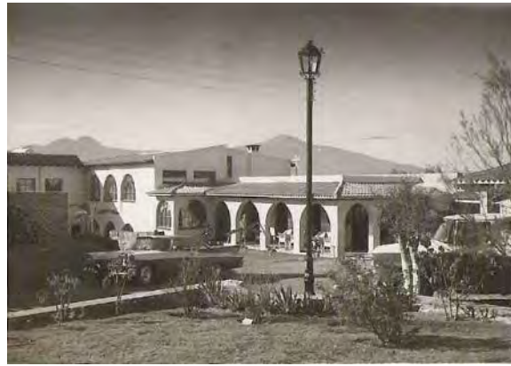
Fotografía 19. Hotel Posada Vista Bella. Durante su construcción. Proporcionada por la Dra. Catherine R. Ettinger.
