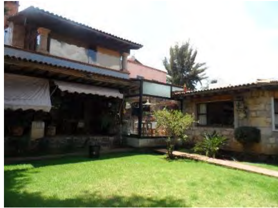
Fotografía 66. Fachada interior casa principal y habitación para huéspedes. Autor: ES. EL.
