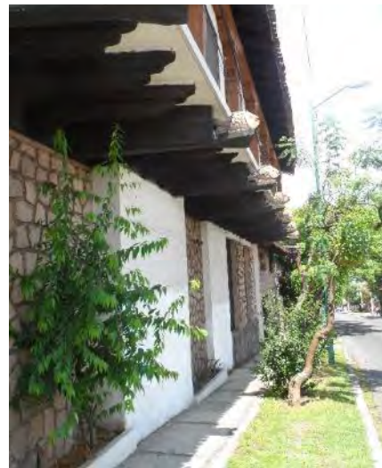
Fotografía 81. Ménsulas de madera con peces de cantera, en fachada norte de la escuela de inglés. Autor: ES.EL
