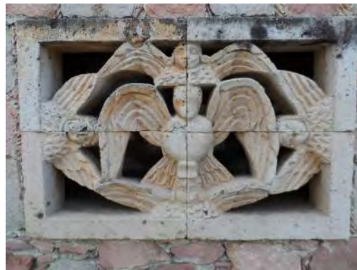
Fotografía 54. Detalle de la Fachada oriente. Autor: ES. EL.
