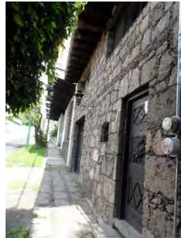
Fotografía 39. Fachada con detalles de tejamanil. Autor: ES. EL.
