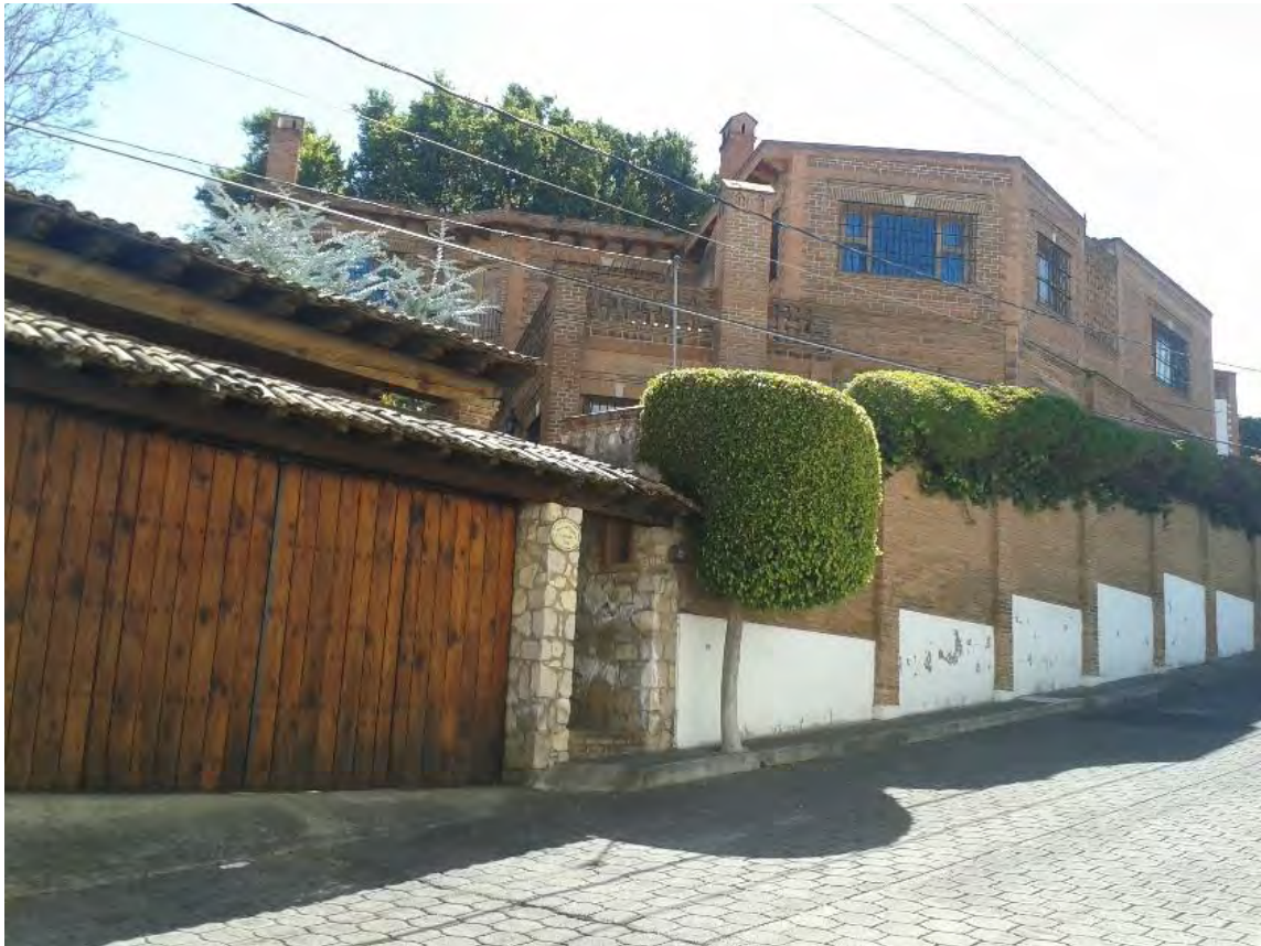
Fotografía 49. Fachada de la casa El Capulín. Autor: ES. EL.
