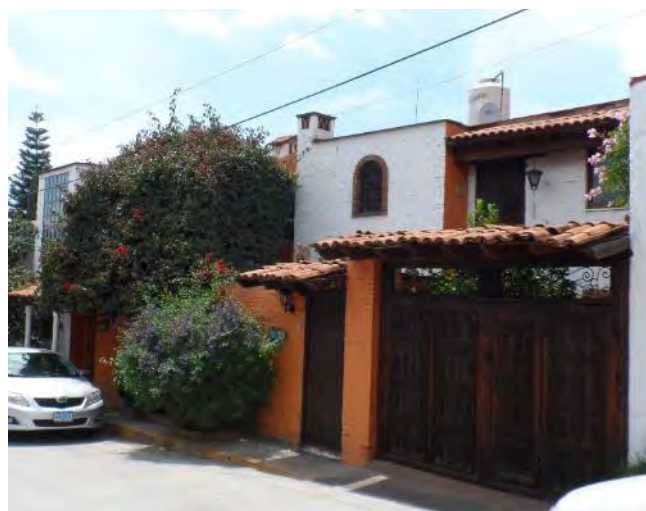
Fotografía 40. Fachada exterior. Autor:ES. EL.
