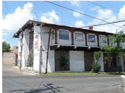
Fotografía 80. Fachada norte. Autor: ES.EL
