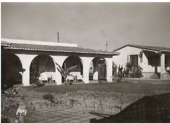
Fotografía 16. Hotel Posada Vista Bella. Durante su construcción. Proporcionada por la Dra. Catherine R. Ettinger.
