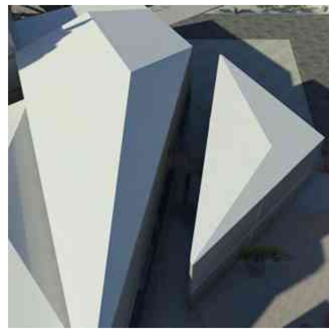
DETALLE EXTERIOR DE LAS CUBIERTAS DE LA GALERIA
