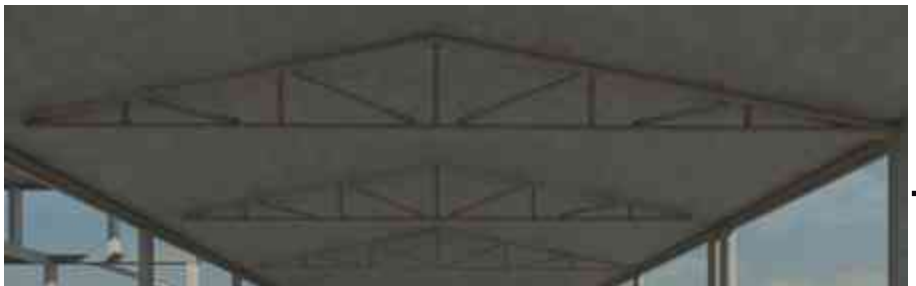
DETALLE INTERIOR DE LA CUBIERTA DEL AUDITORIO
