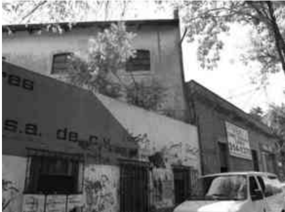
Imagen 03. Perspectiva de Fachada Noroeste. Fabrica en deterioro, sin ninguna función en la actualidad.
