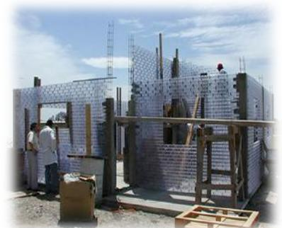
**Imagen 156.** "LADRILLOS PET". El elemento principal están hechos de botellas de plástico prensadas entre si. Fuente: (<http://www.ecologiaverde.com/ladrillos-ecologicos/>)
