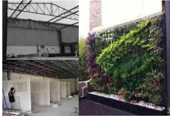
FIG. 5.9 Diferentes tipos de muros, 1) muro de lámina, 2) muro de tablaroca, 3) muro verde.
