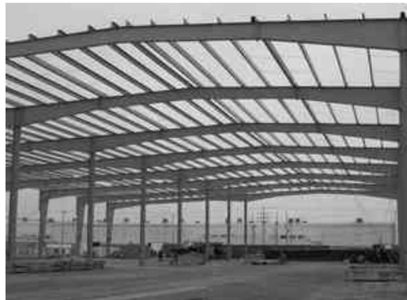
FIG. 5.2 Estructura de acero donde se pueden apreciar las vigas así como los claros que alcanza a librar.
