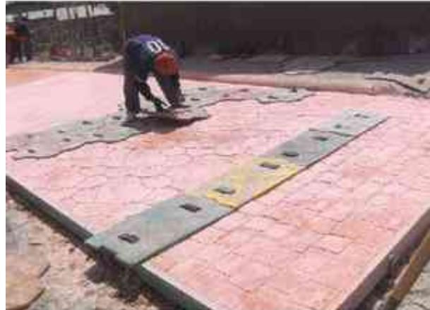
FIG. 5.13 Concreto estampado por medio de moldes alineados con diferentes texturas para exterior.
