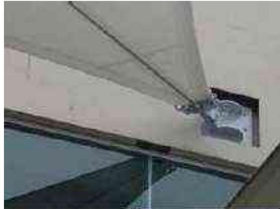
FIG. 5.8 Imagen de anclaje exterior sujetándose a muro.
