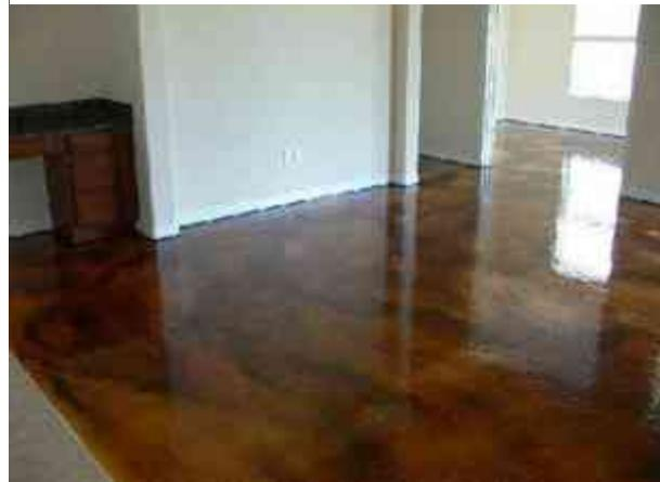
FIG. 5.14 Concreto estampado para interiores con acabado pulido.
