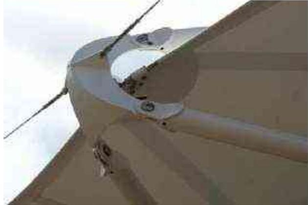
FIG. 5.6 Imagen de relingas, en este caso de fibra de vidrio, también pueden ser de cable metálico.
