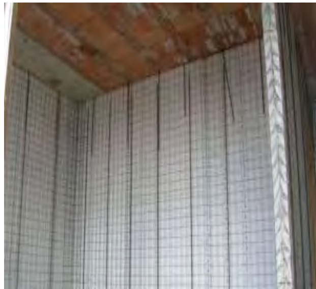
Fig. 104 Muestra la colocación de los muros de panel W / Fuente: Foto tomada por OME
