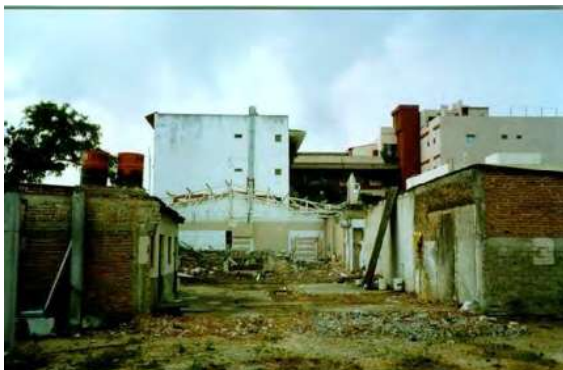
Fig. 75 Muestra el lugar en proceso de limpieza posterior a la demolición / Fuente: Foto tomada por OME
