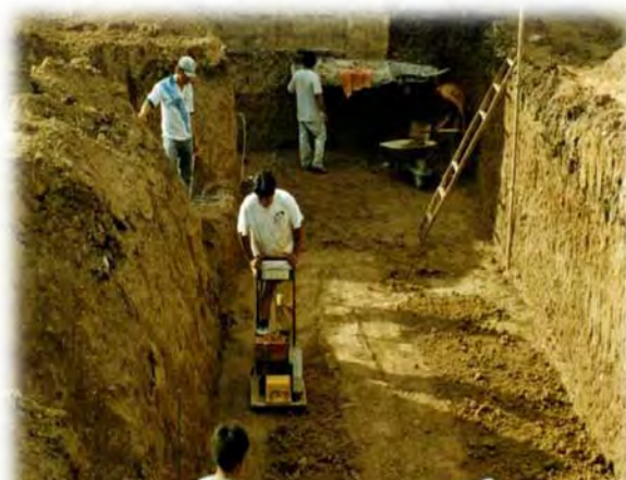
Fig. 79 Muestra el trabajo de afine de taludes y compactación del terreno natural para recibir plantilla de concreto / Fuente: Foto tomada por OME
