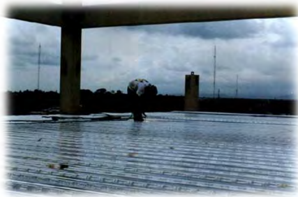
Fig. 97 Muestra el proceso de la colocación de la losa acero en la estructura metálica por medio de la soldadura / Fuente: Foto tomada por OME
