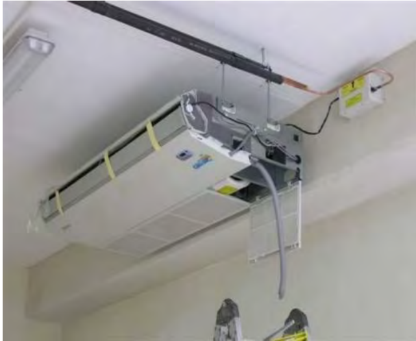
Fig. 118 Muestra la colocación de los aires acondicionados / Fuente: https://www.google.com.mx/search?q=imagenes+d
