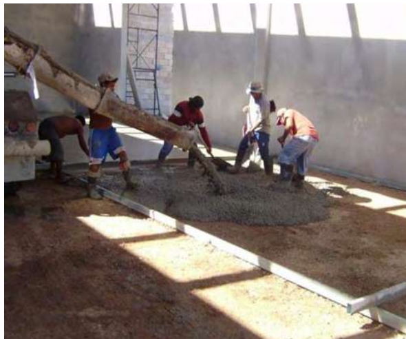
Fig. 107 Muestra la colocación del concreto para pisos / Fuente: Foto tomada por OME
