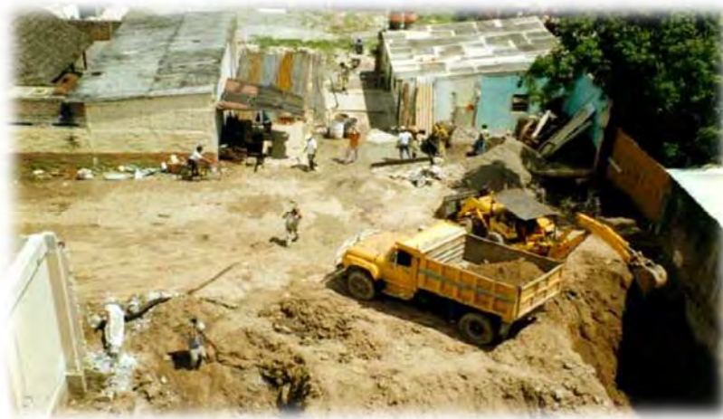
Fig. 78 Muestra el proceso de retiro de tierra producto de excavación de tierra por medios mecánicos / Fuente: Foto tomada por OME
