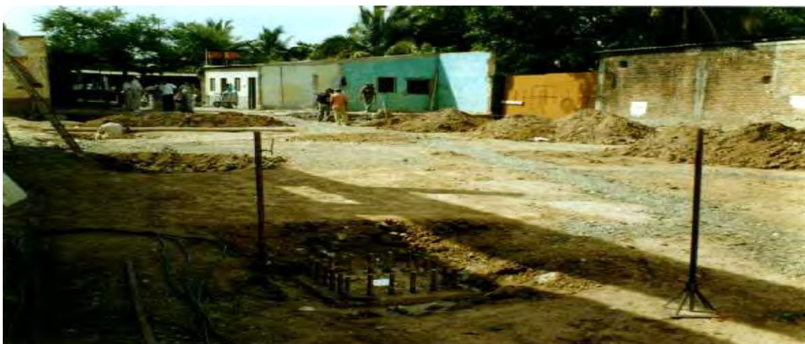
Fig. 91 Muestra el nivel compactado del terreno de acuerdo a los niveles establecidos en el proyecto / Fuente: Foto tomada por OME
