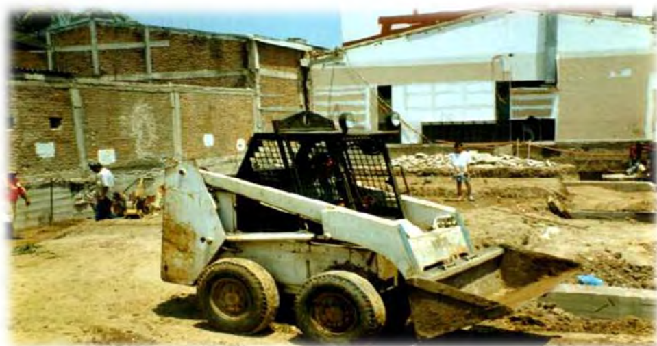
Fig. 88 Muestra el nivel compactado del terreno de acuerdo a los niveles establecidos en el proyecto en la etapa final del relleno y compactación del terreno para recibir a la estructura metálica / Fuente: Foto tomada por OME
