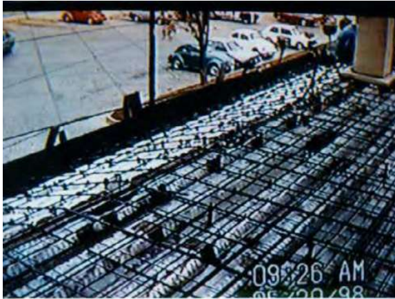
Fig. 100 Muestra la colocación de la estructura con la losa acero en su etapa final / Fuente: Foto tomada por OME
