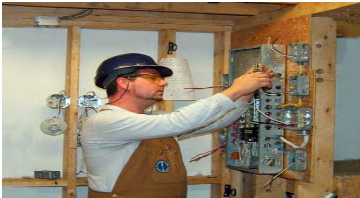
Fig. 116 Muestra la colocación de los tableros eléctricos / Fuente: https://www.google.com.mx/search?q=imagenes+de+cerrajeria
