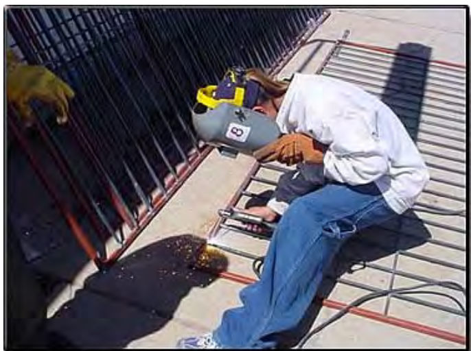
Fig. 112 Muestra trabajos de herrería en obra/ Fuente: https://www.giosoogle.com.mx/search?q=imagenes+de+herreria
