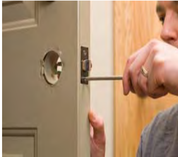
Fig. 113 Muestra la colocación de las chapas en puertas / Fuente:
