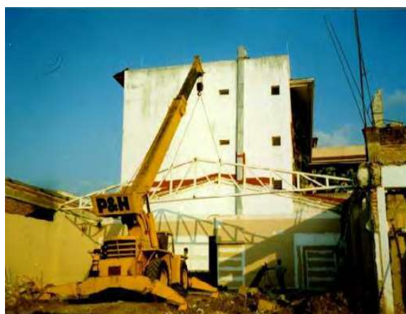
Fig. 71 Muestra el proceso de retiro de la estructura metálica del salón de usos múltiples ya demolido / Fuente: Foto tomada por OME
