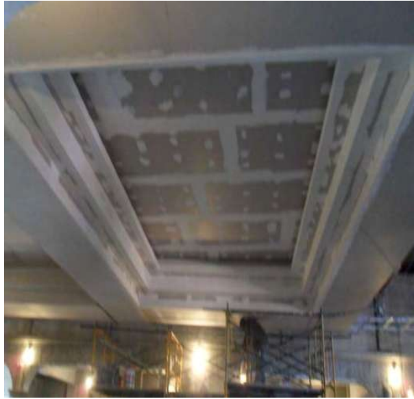
Fig. 108 Muestra la colocación de tabla-roca para recibir acabado final / Fuente: https://www.google.com.mx/search?q=imagenes+de+tablaroca
