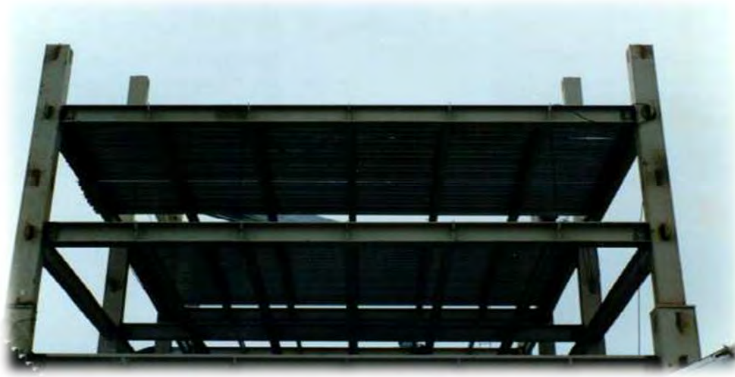
Fig. 99 Muestra la colocación de la estructura con la losa acero en su etapa final / Fuente: Foto tomada por OME
