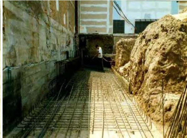
Fig. 83 Muestra La colocación del armado de la zapata corrida lecho inferior y superior / Fuente: Foto tomada por OME
