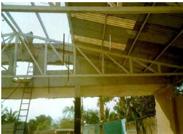
Fig. 70 Muestra el proceso de desmantelamiento del salón de usos múltiples a demoler / Fuente: Foto tomada por OME
