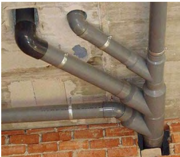
Fig. 111 Muestra la colocación de la tubería de las bajadas de aguas negras / Fuente: Foto tomada por OME
