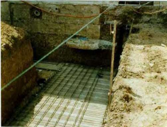
Fig. 82 Muestra La colocación del armado de varillas sobre la plantilla de / Fuente: Foto tomada por OME
