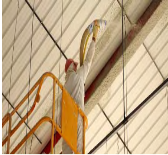
Fig. 95 Muestra la aplicación de pintura a la estructura en campo / Fuente: Foto tomada por OME
