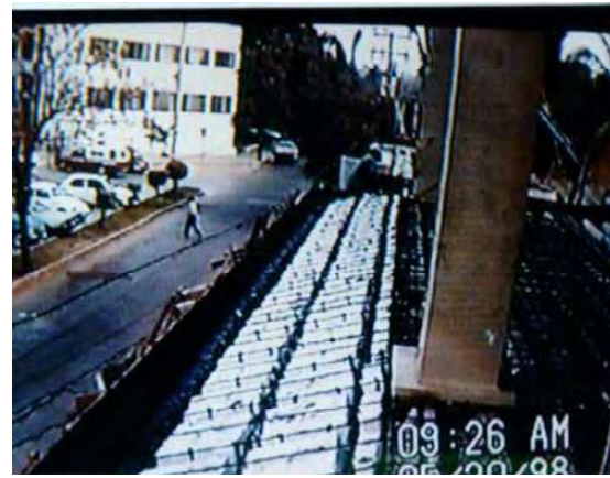
Fig. 101 Muestra la colocación de los casetones para la losa aligerada / Fuente: Foto tomada por OME
