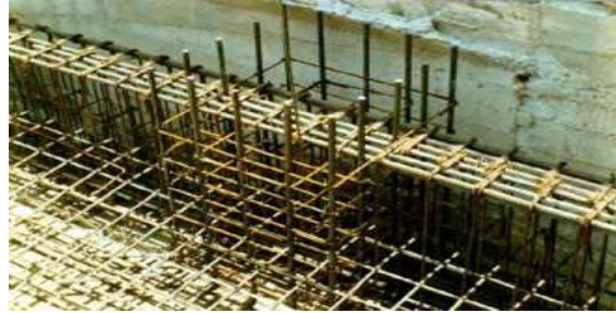
Fig. 85 Muestra el armado del acero en el área de los dados para recibir las columnas de estructura metálica / Fuente: Foto tomada por OME
