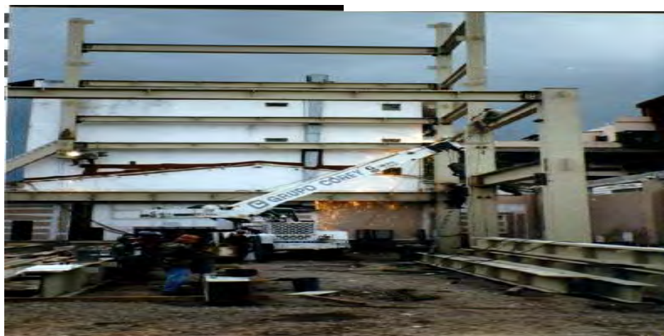
Fig. 92 Muestra el proceso de la colocación de las columnas y traves de estructura metálica / Fuente: Foto tomada por OME
