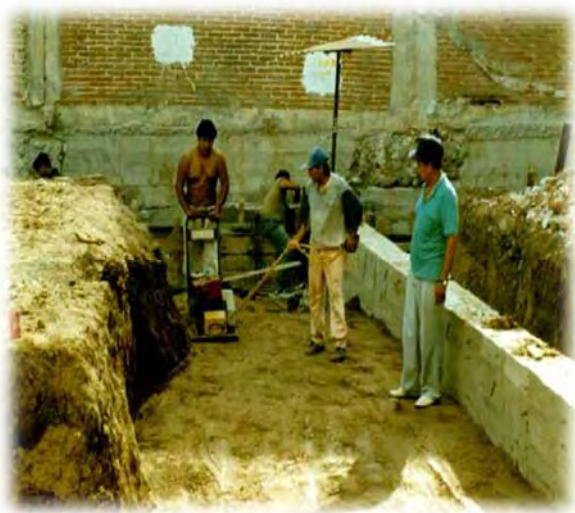
Fig. 90 Muestra el proceso de compactación / Fuente: Foto tomada por OME
