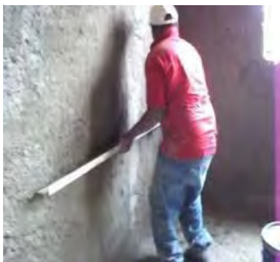
Fig. 106 Muestra la forma de aplanado en muros con regla / Fuente: Foto tomada por OME
