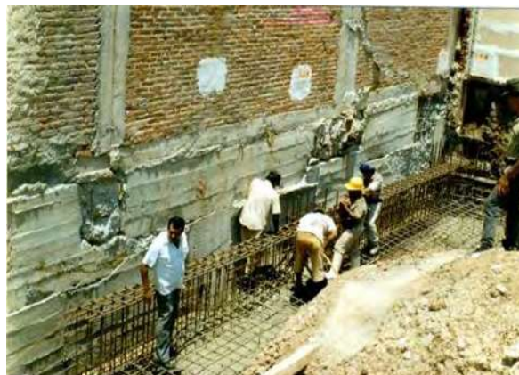
Fig. 87 Muestra la supervisión de la dirección de obra en el momento del vaciado del concreto / Fuente: Foto tomada por OME
