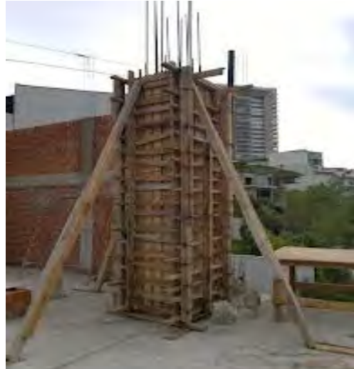
Fig. 103 Muestra la colocación del cimbrado de columna armada de Varilla / Fuente: Foto tomada por OME
