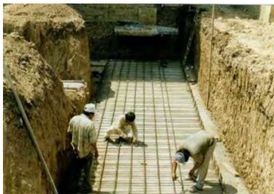
Fig. 81 Muestra La colocación del armado de varillas sobre la plantilla de / Fuente: Foto tomada por OME
