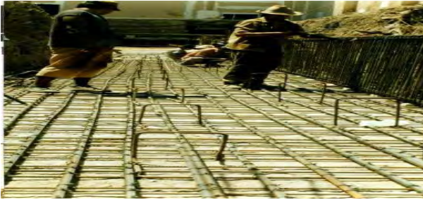
Fig. 84 Muestra el proceso de colocación y armado del tendido del acero de la parte inferior y la colocación de la trabe de desplante / Fuente: Foto tomada por OME
