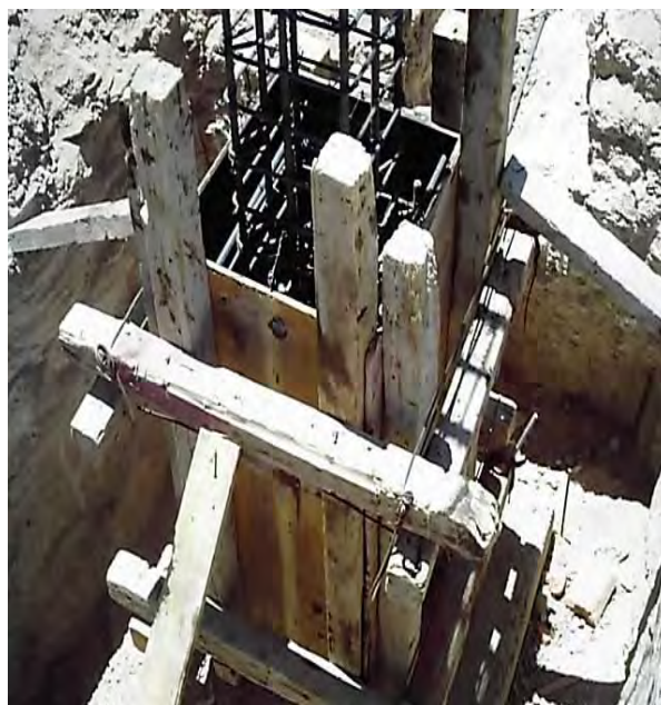
Fig. 103 Muestra la colocación del cimbrado del dado armado de Varilla / Fuente: Foto tomada por OME
