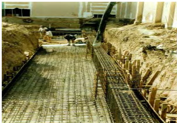
Fig. 86 Muestra el vaciado del concreto premezclado en la cimentación / Fuente: Foto tomada por OME
