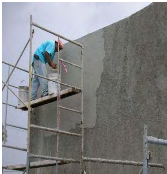
Fig. 105 Muestra el proceso del aplanado / Fuente: Foto tomada por OME
