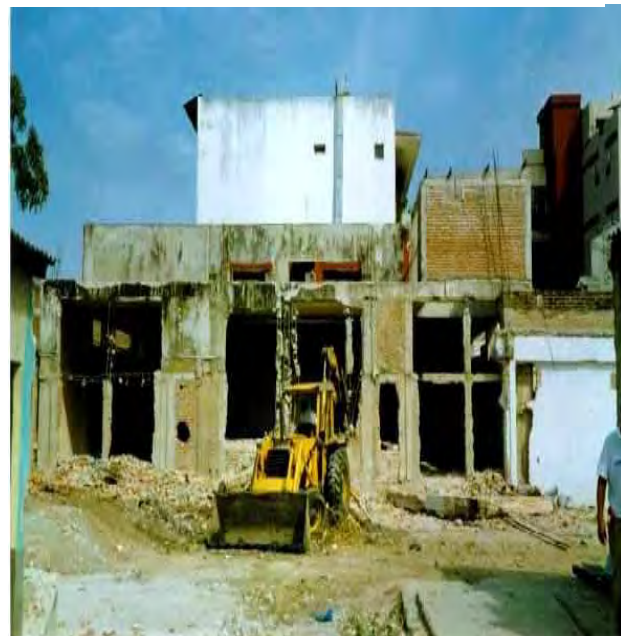
Fig. 73 Muestra el proceso de demolición de los muros de tabique del salón de usos múltiples e en proceso de demolición / Fuente: Foto tomada por OME
