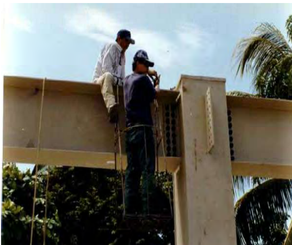
Fig. 93 Muestra el proceso de la colocación de las columnas y traves de estructura metálica / Fuente: Foto tomada por OME
