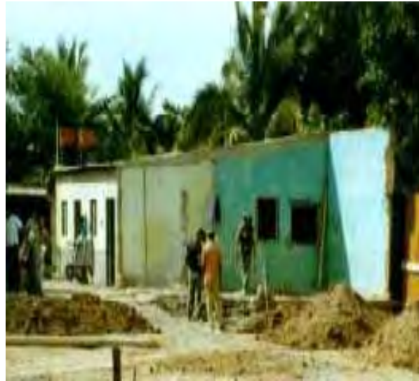
Fig. 74 Muestra el lugar para la habilitación de una bodega para el almacenamiento de material / Fuente: Foto tomada por OME
