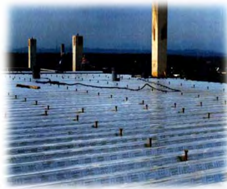
Fig. 98 Muestra la colocación de los pernos en la losa acero para poder recibir el concreto para la losa / Fuente: Foto tomada por OME
