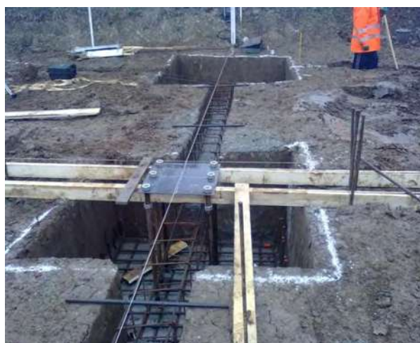
Fig. 94 Muestra la colocación de las anclas para recibir columna metálica / Fuente: Foto tomada por OME
