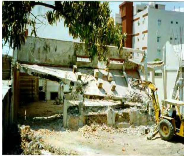
Fig. 72 Muestra el proceso de demolición de la losa de del salón de usos múltiples e en proceso de demolición / Fuente: Foto tomada por OME
