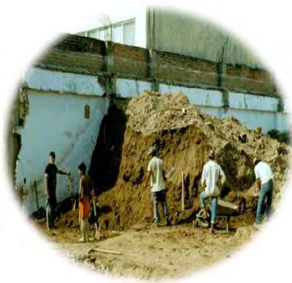
Fig. 89 Muestra el proceso del acarreo del material para relleno y compactación / Fuente: Foto tomada por OME
