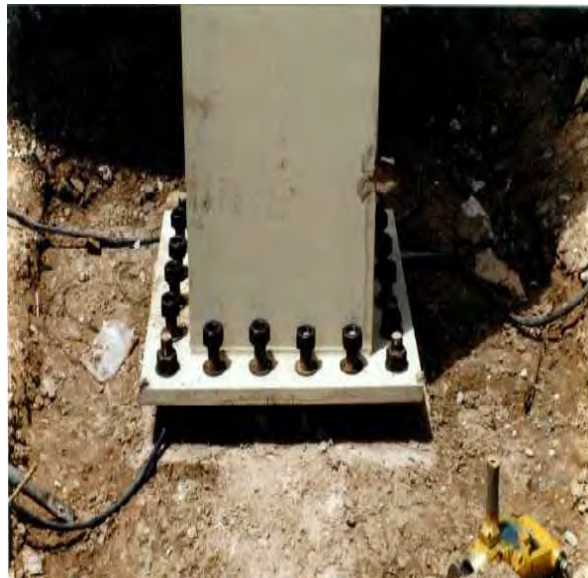
Fig. 96 Muestra la presentación de las tuercas para la nivelación de la estructura metálica / Fuente: Foto tomada por OME
