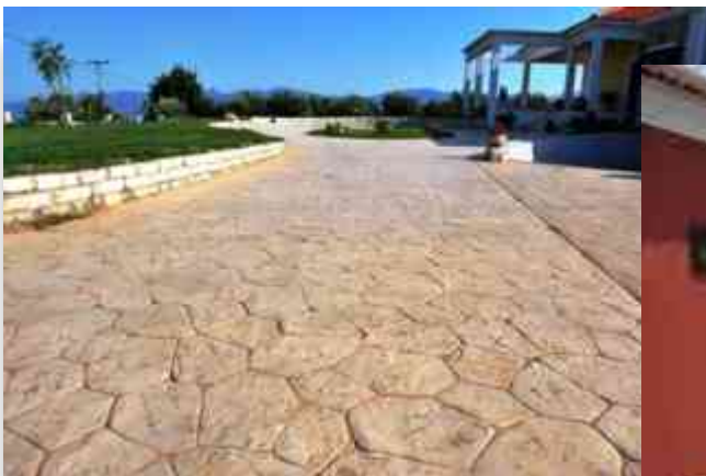
F65. Concreto Pulido Con Acabados
