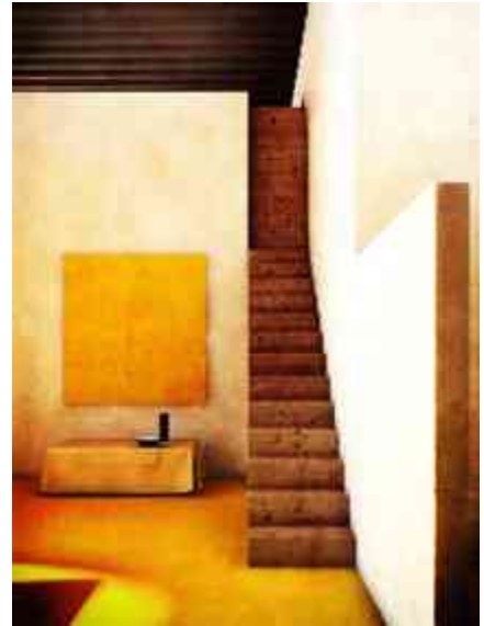
F73. Escaleras En Cantiliber
