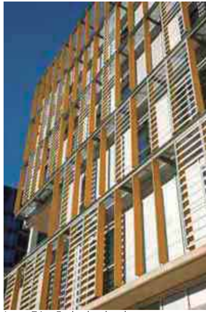
Img. 74.- Fachada donde se muestra el como se evita la entrada del sol al interior.
