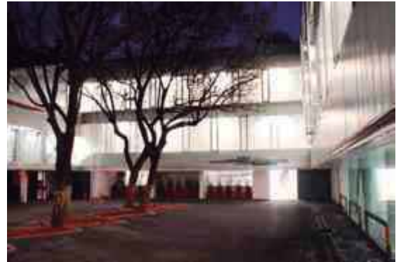
Img. 68.- Corredor perimetral, Fachada vestida con glass cortinas de vidrio.
