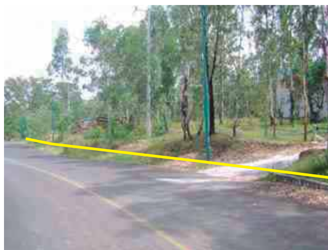
Img. 37- Cableado de alumbrado publico. Tomada por JSB:
