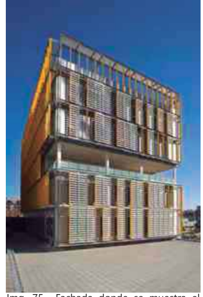
Img. 75.- Fachada donde se muestra el como se evita la entrada del sol al interior.
