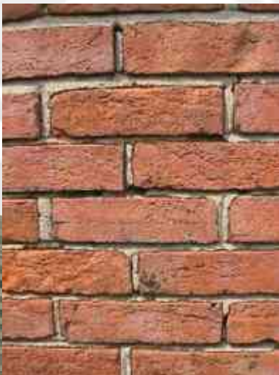
IMAGEN No.87 , muro de tabique , imagen disponible en : http://bricomarias.com/wp-content/2013/01/que-piedras-escoger-para-revestir-un-muro3.jpg , ACTUALIZADA el 23 de junio 2014
