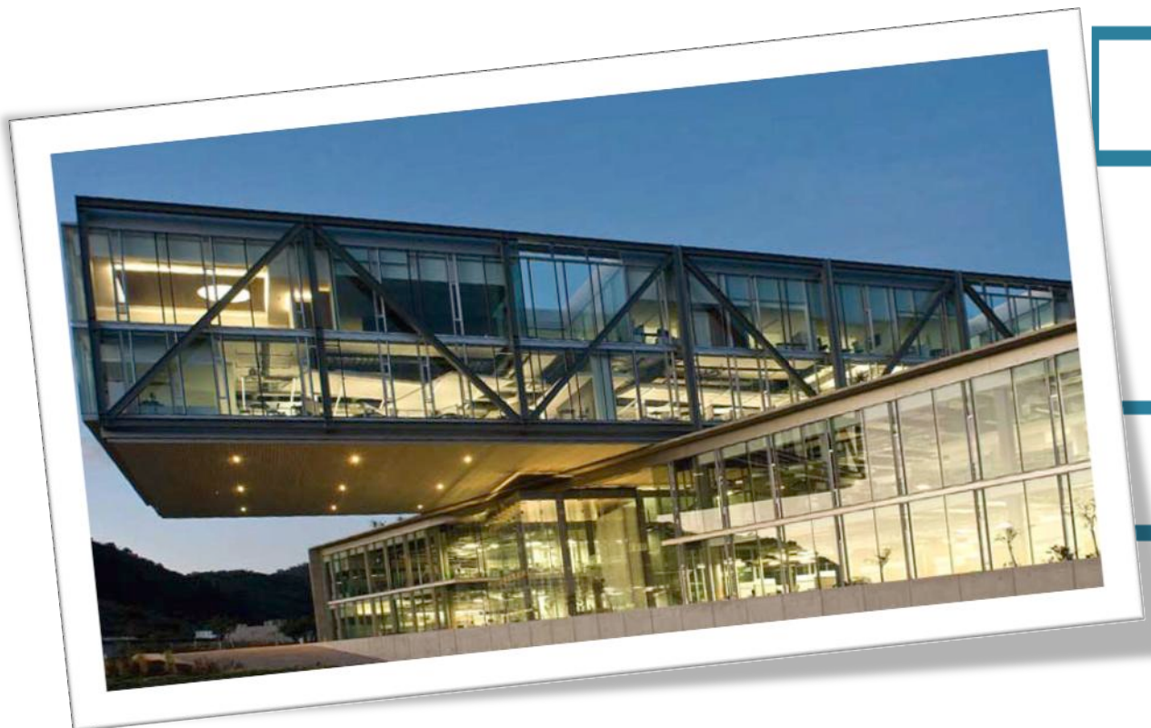
Ilustración 10: Oficinas del corporativo Cinépolis en Tres Marías.
