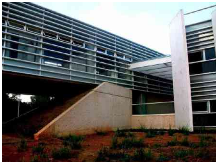
Ilustración 55: Fachada suroeste del edificio del CIAC. Fuente: https://www.facebook.com/media/set/?set=a.1752404221566951.1073741829.1751699328304107&type=3
