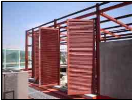
Puertas con PTR y lamina tipo louver con aplicación de primario.
