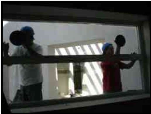
Colocación de cristal en fachadas.
