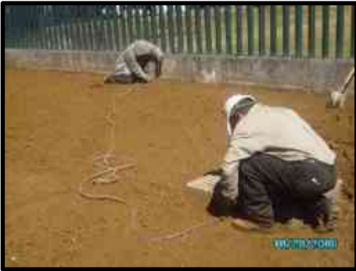
Trazo de jardineras en áreas exteriores.
