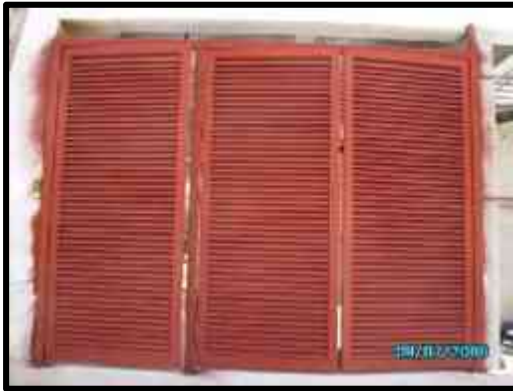
Puertas con PTR y lamina tipo louver con aplicación de primario.
