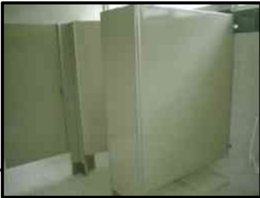
Fabricación y colocación de chambranas de lámina negra, si como la colocación de mamparas del mismo material en sanitarios.
