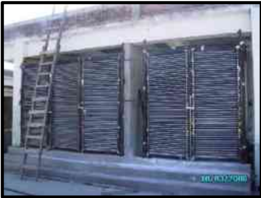
Puertas con PTR y lamina tipo louver con aplicación de primario.
