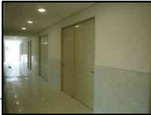
Colocación de puertas de lámina cal. 18.
