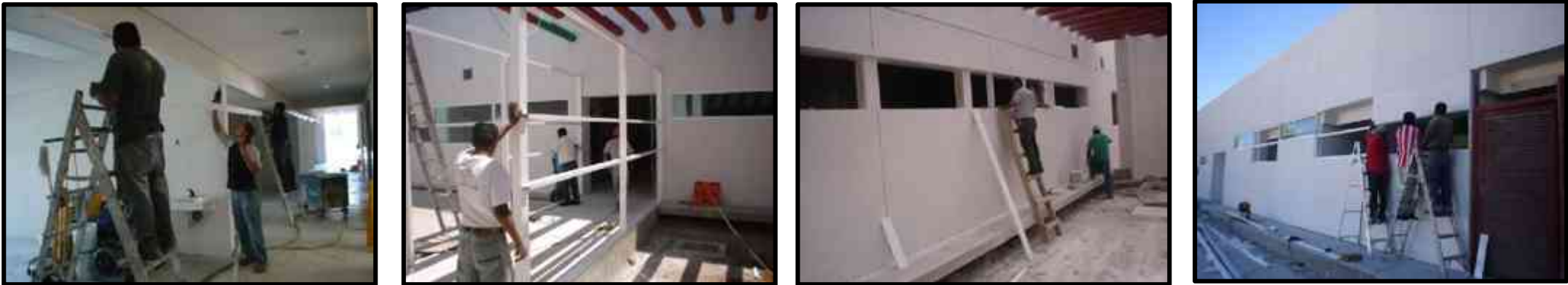
Suministro y colocación de aluminio en color blanco en fachadas e interiores del edificio.
