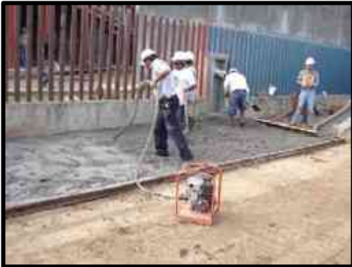
Colado de banquetas y pavimentos en áreas exteriores al edificio.
