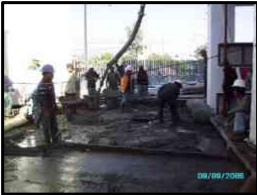
Colado de firmes de concreto.
