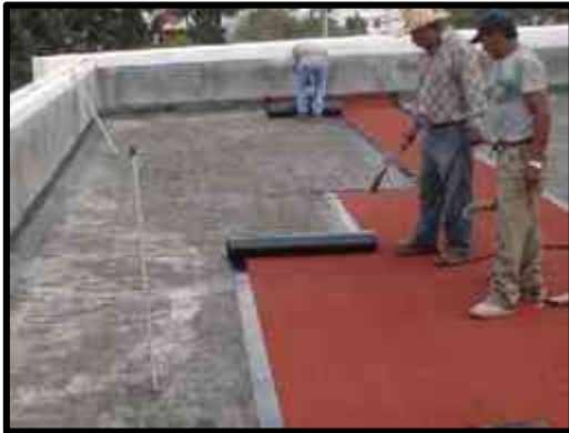
Aplicación de impermeabilizante prefabricado.
