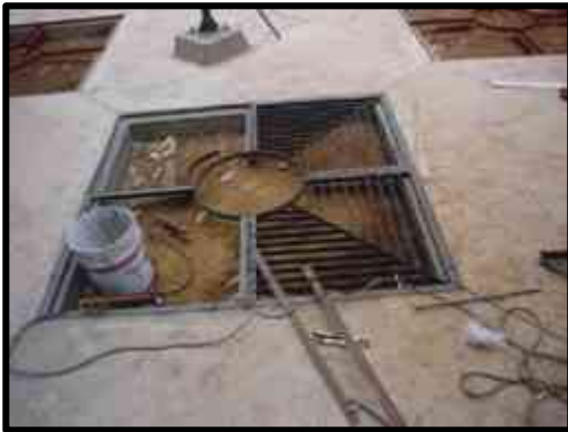
Puertas con PTR y lamina tipo louver con aplicación de primario.
