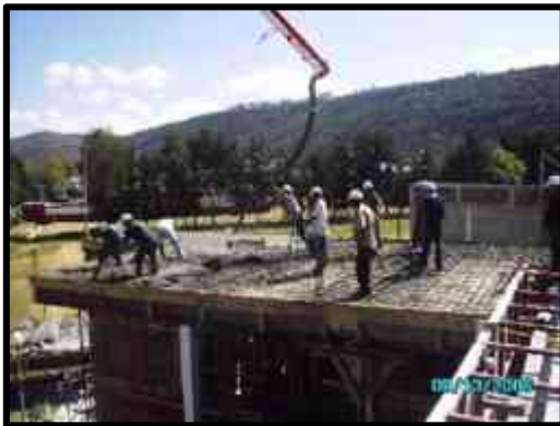
Colado de losas de concreto.
