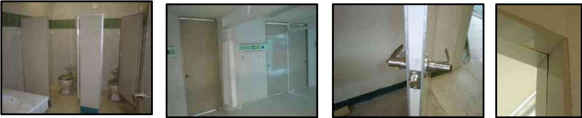
Colocación de mamparas en sanitarios, chambranas y cerrajerías de puertas.
