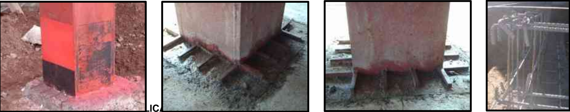
Verificación de anclas y placas en zapatas y colocación de trabes de desplante en cimentaciones faltantes.
