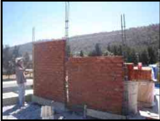
Anclaje de castillos y muros de tabique.
