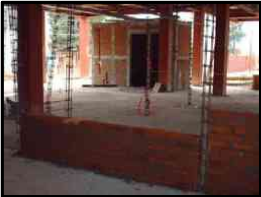
Anclaje de castillos y muros de tabique.
