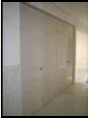
Fabricación y colocación de chambranas de lámina negra, si como la colocación de mamparas del mismo material en sanitarios.
