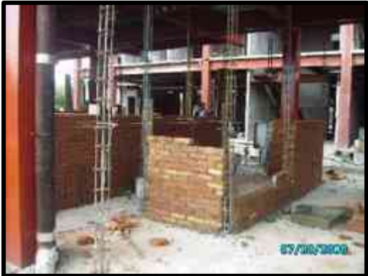
Anclaje de castillos y muros de tabique.
