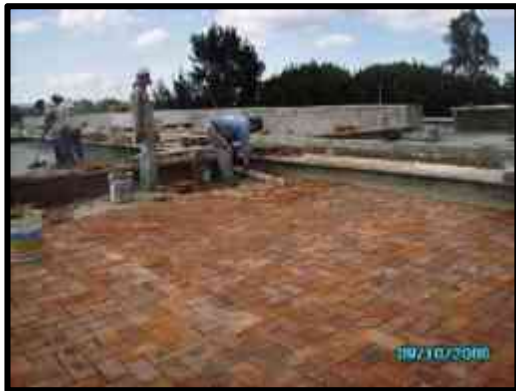
Enladrillado de losa de azotea.
