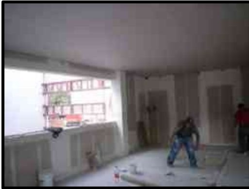
Colocación de muros de tablaroca.
