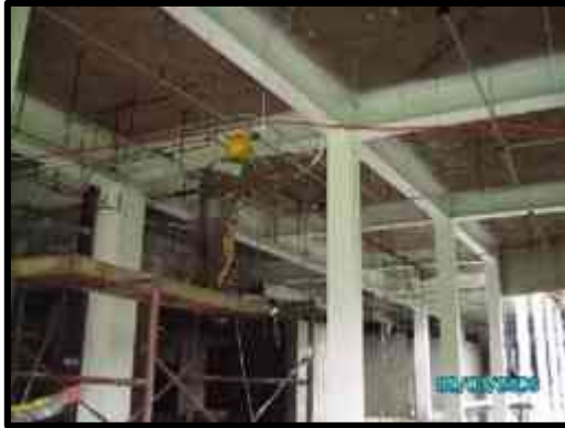
Aplicación de pintura intumescente.
