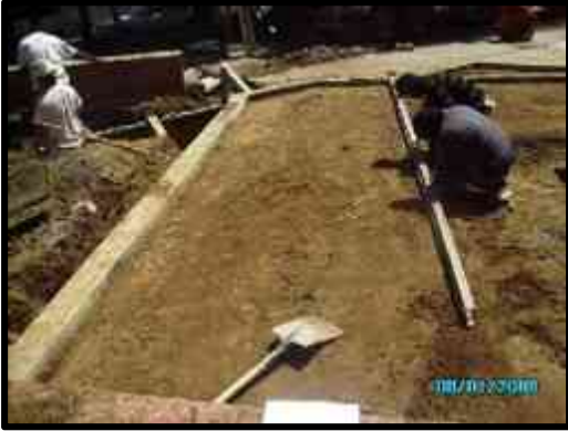
Trazo y colado de pavimentos en áreas de estacionamientos.
