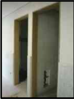
Fabricación y colocación de chambranas de lámina negra, si como la colocación de mamparas del mismo material en sanitarios.
