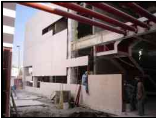
Colocación de placas moduladas (polimérico).
