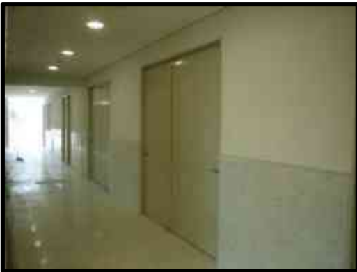
Colocación de puertas de lámina cal. 18.
