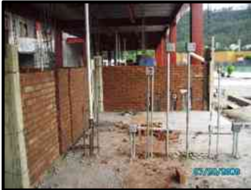
Anclaje de castillos y muros de tabique.
