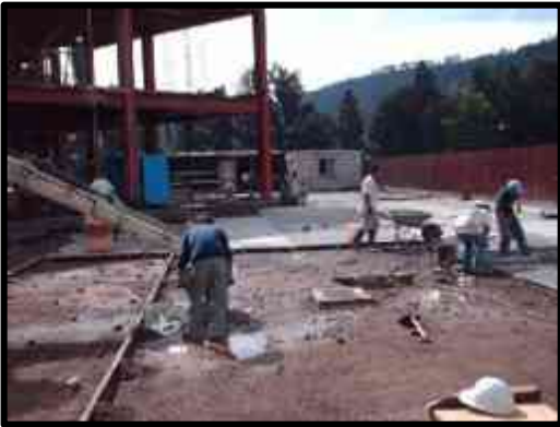
Trazo y colado de pavimentos en áreas de estacionamientos.
