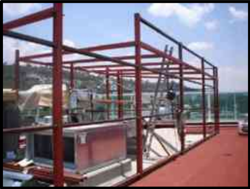
Fabricación bastidores para cuartos de equipos de aire acondicionado en azoteas.
