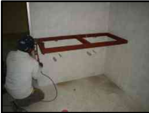
Fabricación de soportes para lavabos
