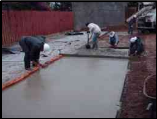
Colado de banquetas y pavimentos en áreas exteriores al edificio.
