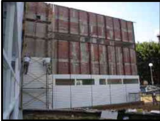
Fabricación bastidores para lamina n fachadas.
