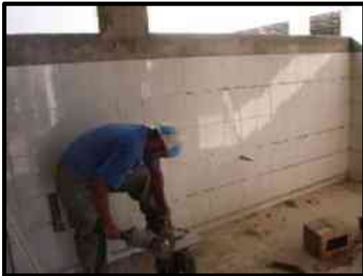
Colocación de recubrimiento vítreo en muros.
