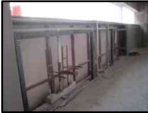
Colocación de herrería en muros.
