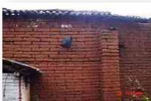
65. Img. Muro de adobe. JJSB. 2104.
