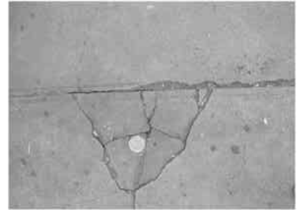
Fig. 92 Piso de los portales de la Explanada
