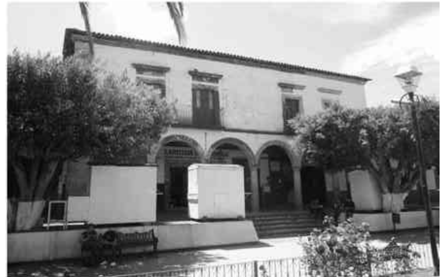
Fig. 32 Fachada de la casa usada en el Canje de Prisioneros
