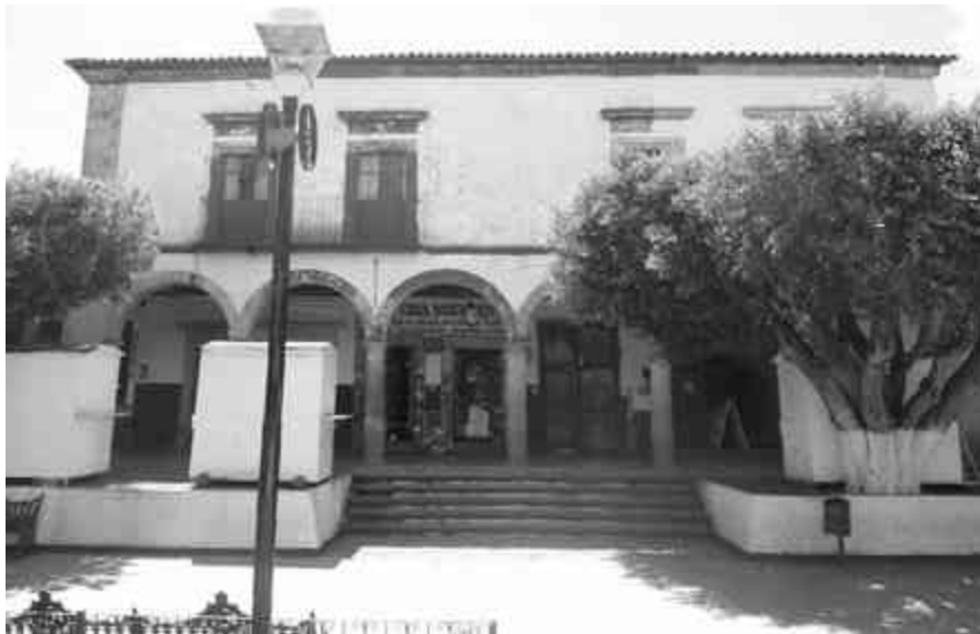
Fig. 31 Fachada de la casa usada en el Canje de Prisioneros
