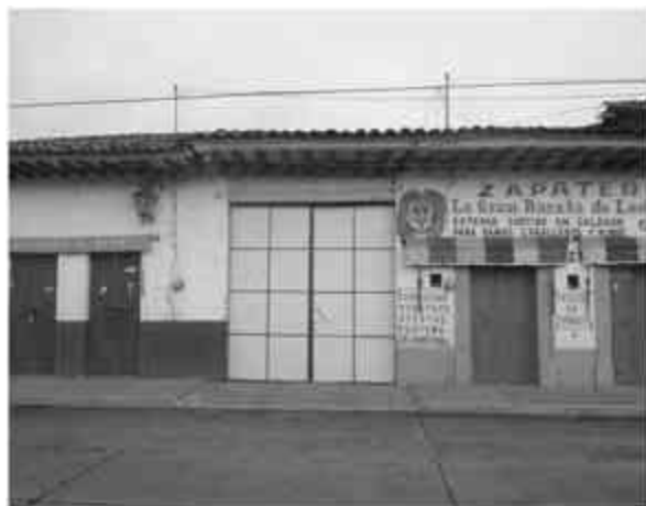
Fig. 35 Fachada Exterior del antiguo Mesón
