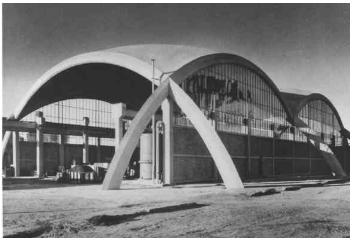
Imagen 8. Vista del área de almacén de amoníacos. Fuente: pinterest.com
