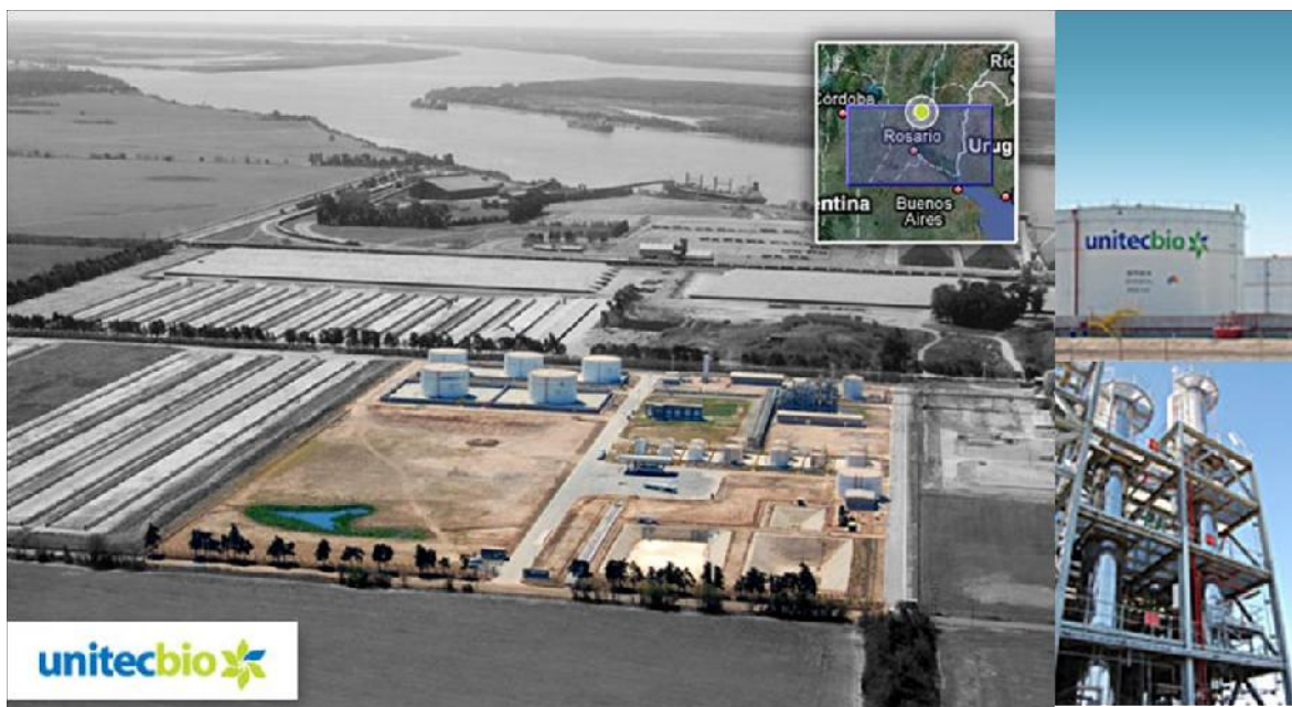
Imagen 4. Planta de biodiesel en el puerto General San Martín, Argentina. Fuente: www.unitecbio.com .
